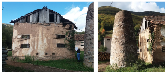
Слика X - оронулост дрвених делова фасаде.
