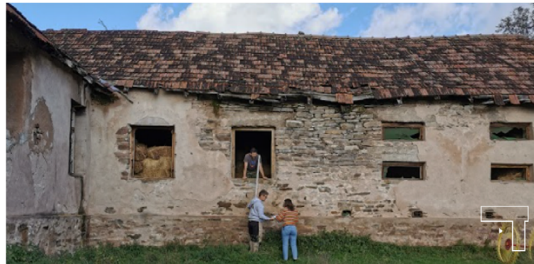
Слика X - Фасада објекта млекаре са југо - источне стране.
