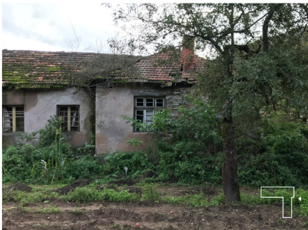
Слика X - Фасада објекта млекаре са северо - западне стране.
