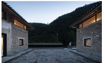
Однос камене фасаде која је резервирана и алтернативног транспарентног сегмента. Истовремено интегрисаност нових профила прозора у некадашње отворе (налик задатом). Блага интервенција у партнерном решењу - обликовање целине
