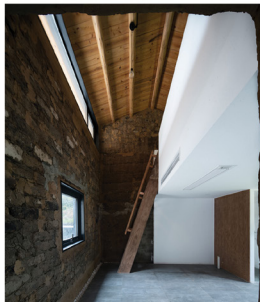
Однос камене фасаде која је резервирана и алтернативног транспарентног сегмента. Истовремено интегрисаност нових профила прозора у некадашње отворе (налик задатом). Блага интервенција у партнерном решењу - обликовање целине
