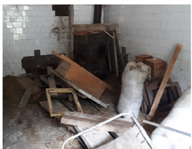
Слика 10 - уклањање отпада
