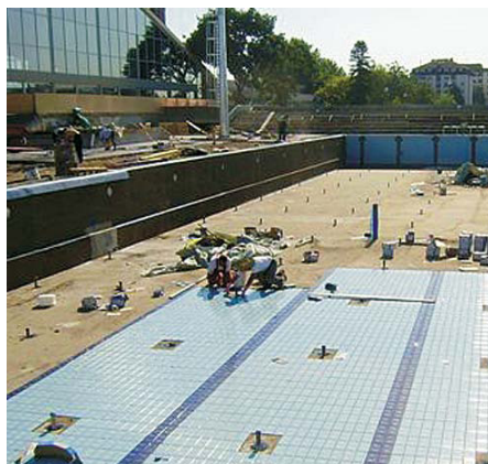
Slika 4: Fleksibilni lepak Elastorapid omogućio je da se keramičke pločice fuguju posle 3 sata.
