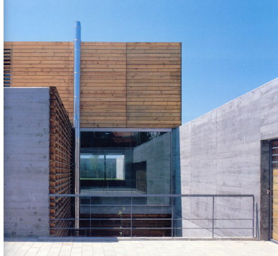
Slika 6. Kombinacija drveta i natur betona na fasadi, Zatvoren bazen, Laracha, A. Coruña, Carlos Quiuntáns, Antonio Raya, Cristóbal Crespo – arhitektonski tim, 1995. godine[7]
