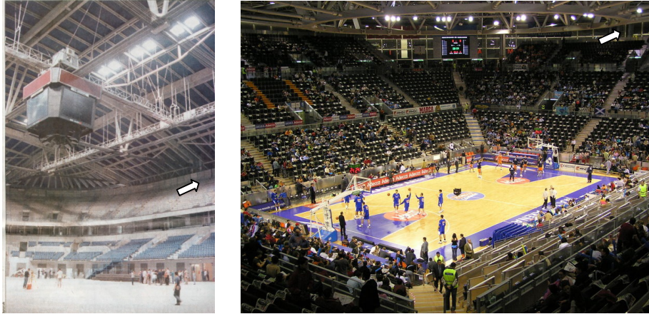
Slika 26. Beogradska arena: blizina sedišta (time i požara) i oslonca zatege; slična slabost arene u Madridu
