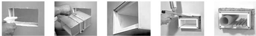
Slika 3. Protivpožarna kutija i njeno instaliranje
