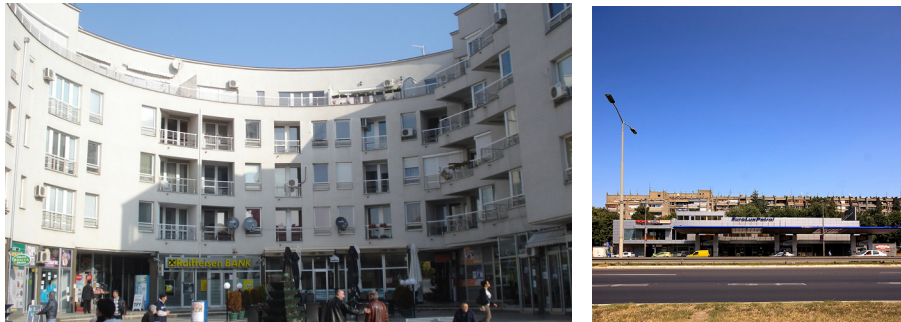
Slika 2 . a) Stambeno-poslovni objekat, Smederevska palanka, Dragan Marčetić i Vukašinić arhitekti, b) Benzinska pumpa Euroluxpetrol, Novi Beograd, Dragan Marčetić i Miodrag Mirković arhitekti
