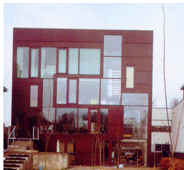
Slika 11. Fasada od kompozitnih ploča u kombinaciji sa velikim površinama u staklu, Double House (Villa KBWW), Utrecht, The Netherlands, Architect de architectgroep ang MVRDV- arhitektonski tim, 1997. godine[12]
