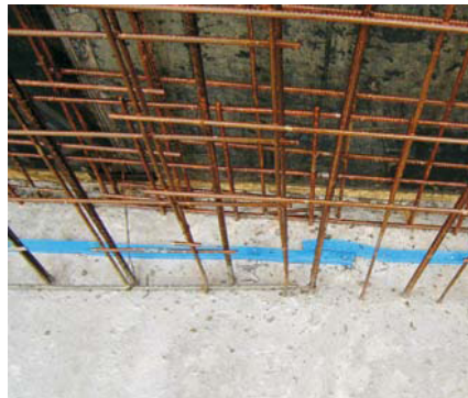
Slika 7: Kod prekida betoniranja za postizanje vodonepropusnosti spojeva primenjuju se hidrofilne ekspandirajuće trake Idrostop.
