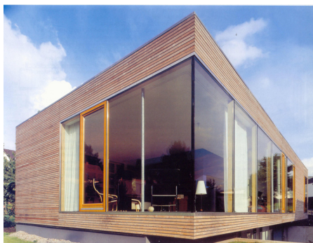
Slika 10. Kombinacija drvene obloge i velikih staklenih površina na fasadi, Porodična kuća, Detmold, Habermann, Stock, Decker arhitekten - arhitektonski tim, 2001. godine[11]
