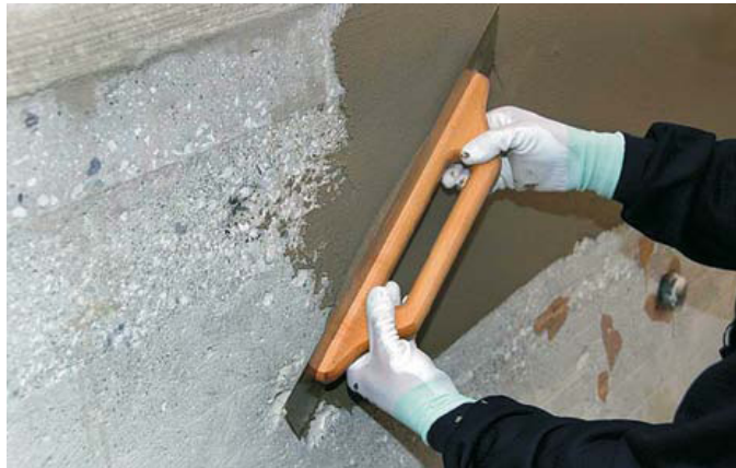
Slika 8: Reprofilacija zidova malterom Planitop Fast 330 omogućava skraćenje roka izvođenja radova.
