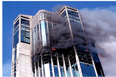
Slika 38. Popuštanje samo jednog stuba (kad ih ima malo) može dovesti do kolapsa cele zgrade; ovoj visokoj zgradi (desno) je pretilo "prelamanje" kolapsom stubova - visina van dohvata lestvi gasilaca
