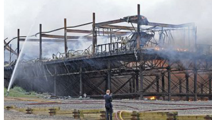
Slika 37. London – izgleda neverovatno da zgradu niko ne gasi: to je bila jedna od više istovremenih paljevina iz "nemira" huligana u Krojdonu; konstrukcije (desno) popuštaju; šta ostaviti u sanaciji ovih kostura
