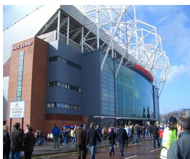
Slika 25. New Old Traford – znatan deo zatega koje nose krov su spolja – neznatno ugrožene požarom /u ovom slučaju ideja je bitno oslabljena izgradnjom bloka poslovnih prostorija koje obuhvataju i donji deo tih triju Γ prostornih konstrukcija
