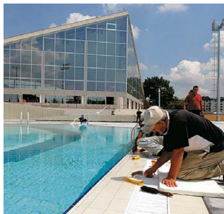
Slika 5: Za fugovanje keramičkih pločica upotrebljena je brzovezujuća masa Ultracolor Plus.
