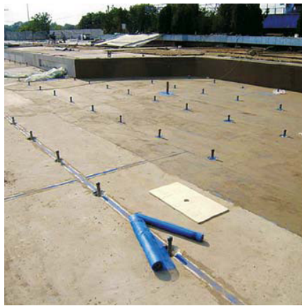
Slika 3: Hidroizolacija i zaštita betonske konstrukcije urađena je u sistemu Mapelastic.
