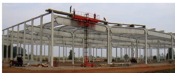
Slika 33. Prefabrikovane AB konstrukcije većih raspona – konstruktor i ne razlikuje spoljašnje i unutrašnje konstrukcije (ovde je očito nekoliko desetina istih stubova i greda - znatno većih od dimenzija peći za ispitivanje konstrukcija na požar – problem definisanja uzoraka za ispitivanje); često se zidovi dobijaju popunjavanjem, oziđivanjem pa primenom ploča od penastih materijala
