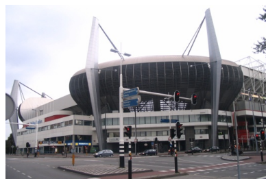
Slika 24. Spoljašnje noseće konstrukcije dve velike arene u Holandiji
