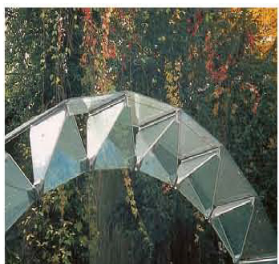
Sl.12. Staklena prizmatična tela formiraju stakleni luk (Wurm, st.14.)
