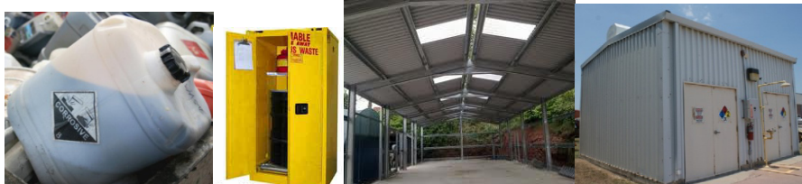
Slika 6 Korozivne materija u plastičnim posudama; ovo je nepropisno, lako se mogu oštetiti i tečnost izlupati; ormar za smeštaj buradi i manjih posuda za otpadne zapaljive tečnosti; nadstrešnica za skladištenje i tipska zgrada sa instalacijama (napolju je tuš za ispiranje kontaminiranog) za osvetljenje
