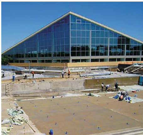
Slika 2: Izravnavanje podova bazena izvedeno je upotrebom hidrauličkog veziva Topcem-a.
