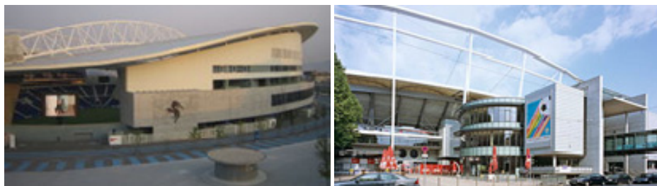
Slika 16. Luk kao prostorna rešetka (stadion Dragao), Stubovi, prsten i zatege koje nose krov 2
