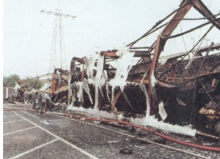
Slika 30. Zgrade koje su lako mogle biti izvedene da i pri požaru veće žestine budu znatno manje oštećene
