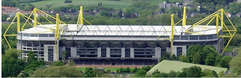
Slika 17. Nemački funkcionalno, stubovi i zatege – nosači krova i konstrukcije koje nose tribine su spolja – zgrada povoljna i za gradove u Srbiji koji još nemaju halu za sport i zabavu mladih (4 – 10000 gledal.)
