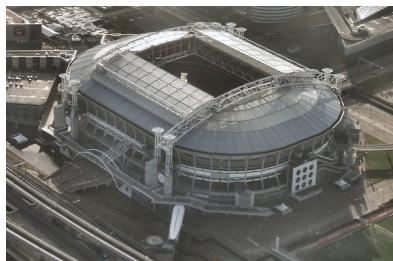
Slika 24. Spoljašnje noseće konstrukcije dve velike arene u Holandiji
