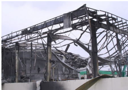
Slika 30. Zgrade koje su lako mogle biti izvedene da i pri požaru veće žestine budu znatno manje oštećene
