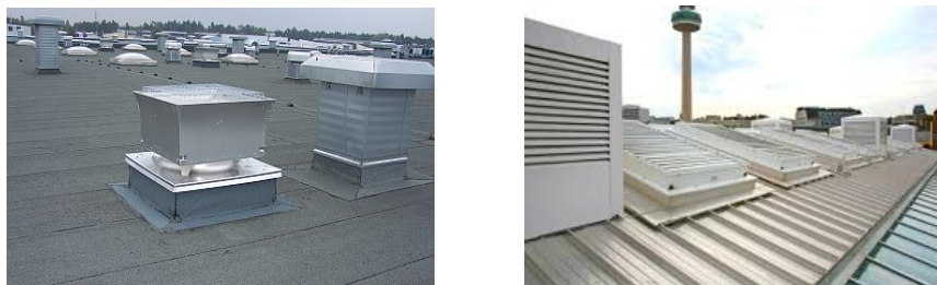
Slika 23. Razna rešenja za ispuštanje dima na krovu mogu da ispuštaju i plamene gasove
