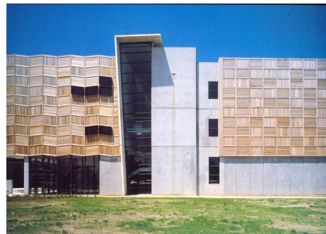
Slika 5. Fasadna drvena obloga izvedena u kombinaciji sa betonskim zidnim platnima, Fakultet za dizajn tekstila, Melburn, Australija, H20 architects – arhitektonski tim, 1999. godine[6]
