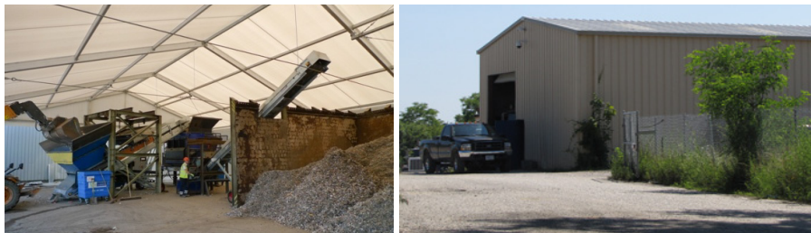
Slika 4 Mašina za usitnjavanje plastike i mekših metala (napr. Al limenki) u skladišnom objektu; izdvojeni montažni objekat – lake čelične konstrukcije (obično nezaštićene od požara pa je bar sumnjivo)
