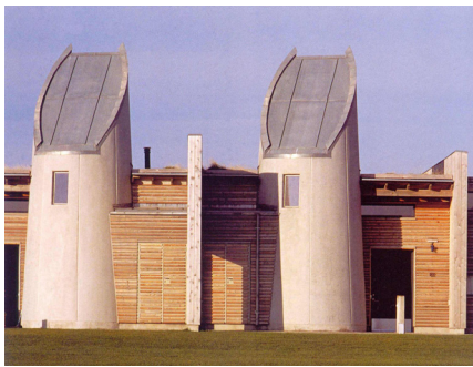
Slika 4. Fasada u kombinaciji natur betona i drvene obloge, Centar za rehabilitaciju, Musholm Bay, Korsor, Denmark, Arkos Arkitekter – arhitektonski tim, 2001. godine[5]
