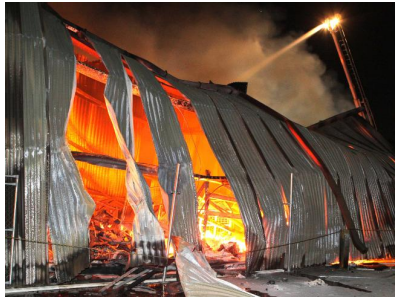
Slika 29. Požar u hali (unutrašnji požar – refleksija zračenja od "zidova" - zgrade bez rešenog odimljavanja
