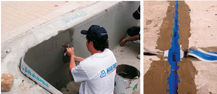
Slika 11: Mapeband trake se koriste za obradu ivica, uglova, prodora i dilatacionih fuga u hidroizolacionom sistemu Mapelastic.
