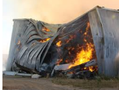
Slika 29. Požar u hali (unutrašnji požar – refleksija zračenja od "zidova" - zgrade bez rešenog odimljavanja
