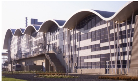
Slika 18. Vitki stubovi van osnove hale; domaća manja hala sa stubovima spolja – prosto i efikasno (za fabričke, skladišne, sportske, pijačne i sl. hale; stubovi izloženi atmosferskim uticajima se lakše štite)
