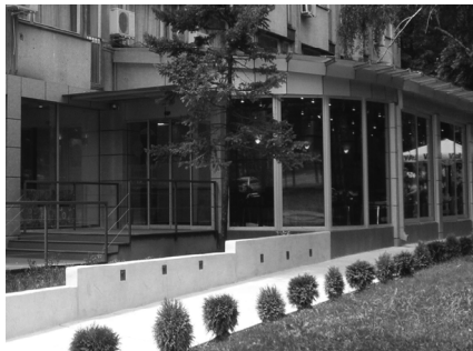
Slika 5. Fasada zimske bašte
