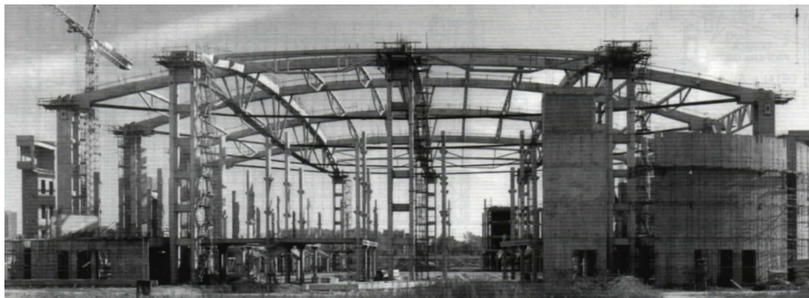
Slika 27. Beogradska arena – vrlo osetljive na zagrevanje prednapregnute užetne konstrukcije (pa još mala rezerva nosivosti cele "kape") pa još u lako zapaljivm plastičnom bužiru ispunjenom mašću!
