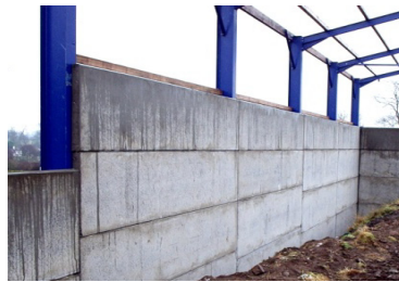
Slika 18. Vitki stubovi van osnove hale; domaća manja hala sa stubovima spolja – prosto i efikasno (za fabričke, skladišne, sportske, pijačne i sl. hale; stubovi izloženi atmosferskim uticajima se lakše štite)
