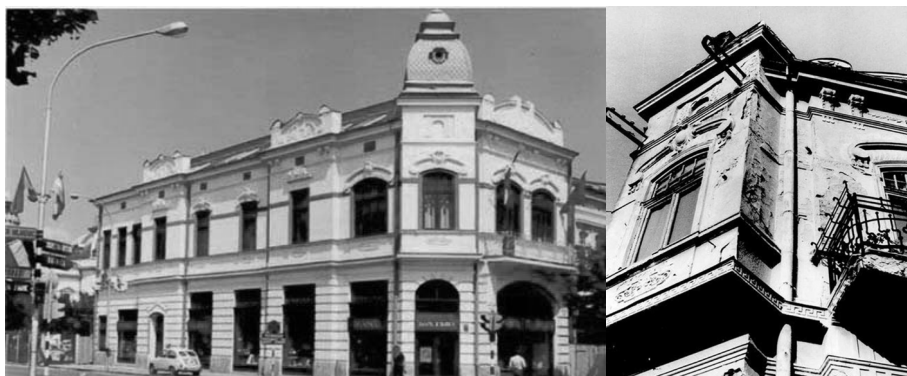
Слика 3 – Детаљ угаоног дела фасаде пре обнове и ревитализације објекта (лево, 1977). Изглед објекта после обнове и ревитализације (десно 1978, аутор фотографија Александар Радојевић)
