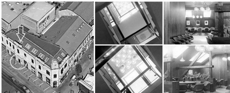
Слика 6 – Изглед крова са уграђеним кровним прозорима у равни крова. Стрелицом је означен прозор изнад централне вертикалне комуникације, а кругом улаз из улице 27. марта (лево, фотографија преузета са Google Earth-а). Нова централна вертикална комуникација која повезује све нивое у објекту (у средини, горе и доле, аутор фотографија Љуба Костић, 1978). Поткровље, после обнове и ревитализације, намењено за промоције књига и сличне намене (десно, горе и доле, аутор фотографија Љуба Костић, 1978)
