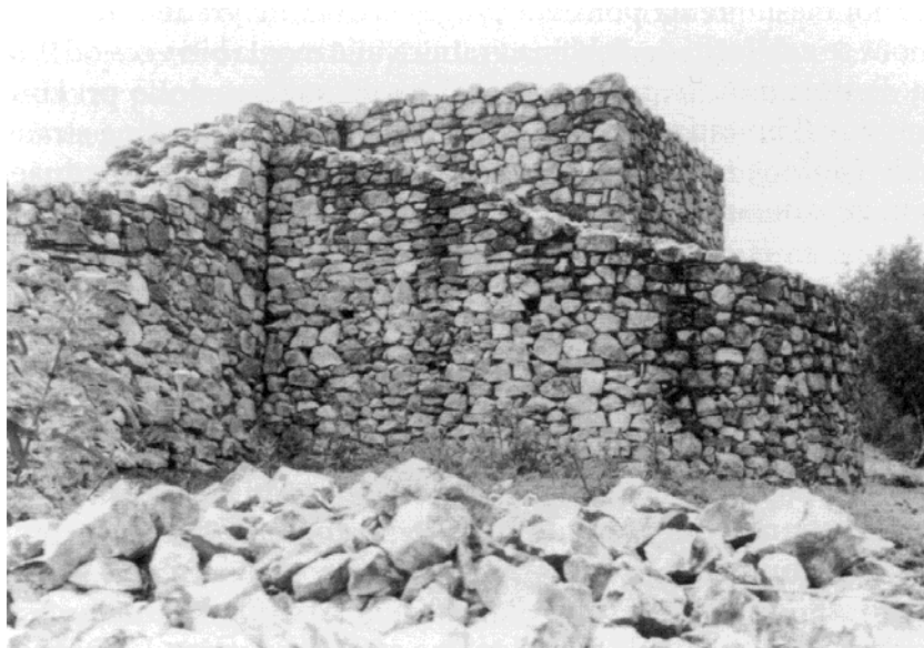
Сл. 44 – Остаци куле II, изглед у унутрашњости са првобитним подом (горе) и спољна страна куле са полукружним ојачањем после конзерваторских радова (доле), (М. Поповић, Тврђава Рас, стр. 179.)
