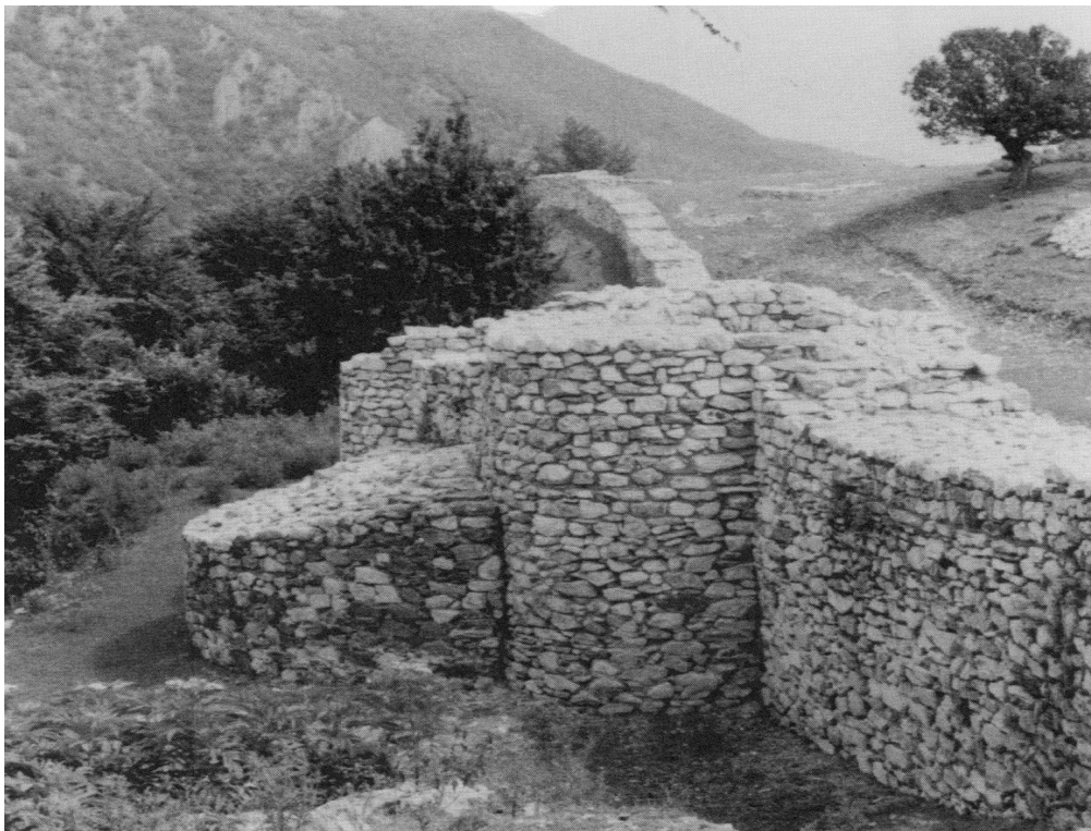
Сл. 45 – Западна капија, унутрашњи изглед после делимичне обнове (горе) и спољни изглед после конзерваторских радова (доле), (М. Поповић, Тврђава Рас, стр. 179 и 182.)
