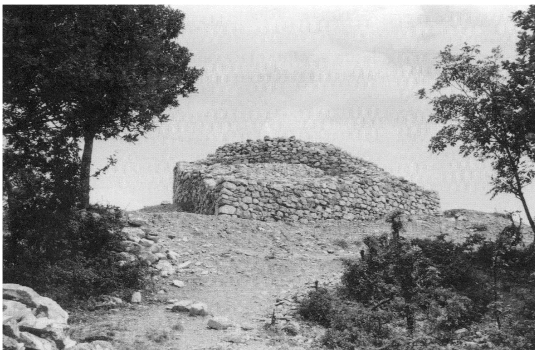
Сл. 41 – Призидано ојачање са јужне стране код главне донжон куле после конзерваторских радова, (М. Поповић, Тврђава Рас, стр. 177.)
