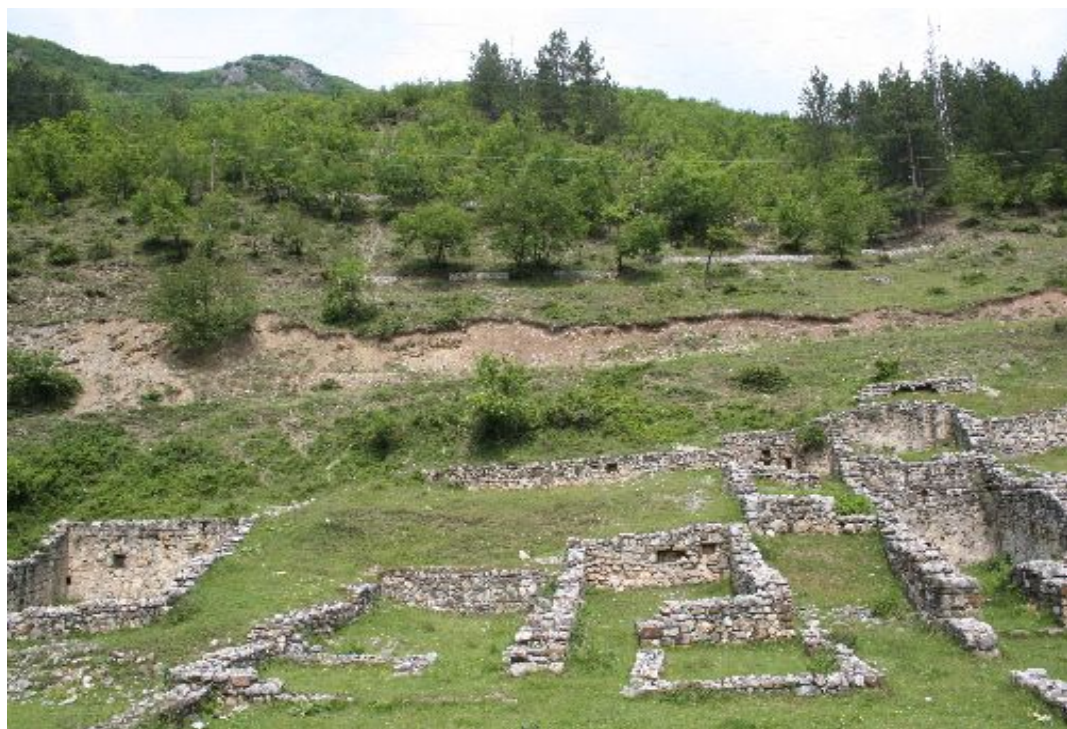
Сл. 59 – Пазариште, постојеће стање конзервираних кућа уз пут, ( https://www.google.rs/search?q=stari+ras&tbm=isch&tbo=u&source=univ&sa=X&ei=2CCKUpem )
