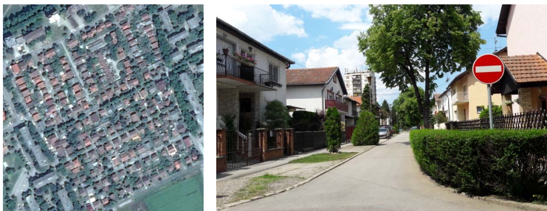
Слике 104 и 105: Насеље слободно стојећих кућа у Сомбору (извор: Сл. 104: Google Earth / Street View; Сл. 105: Б. Антонић)
