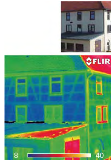
Откривање конструкције зидова и утврђивање могућих оштећења. Објект са дрвеном конструкцијом. Definition of structural elements of façade walls and inspection for damages. Building with wooden construction.
