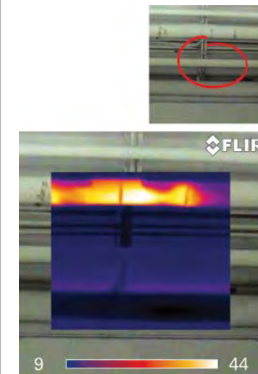
Откривање зачепљења као и цурења цеви сакривених у оквиру конструкција. Detection of blockages as well as leakages of pipes hidden within the construction.
