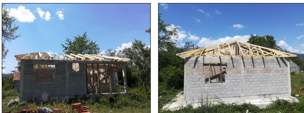
Slika 4. Realizovana krovna konstrukcija
