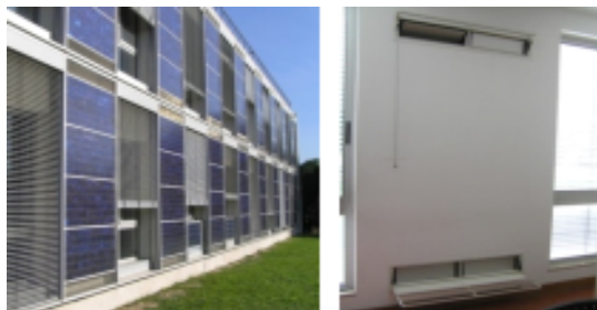
Slika 8. Poslovna zgrada Solar Building XXI, Lisabon. Dupla fasada sa PV modulima (levo) i pozicija otvora za cirkulaciju vazduha (desno). Izvor: Autor
