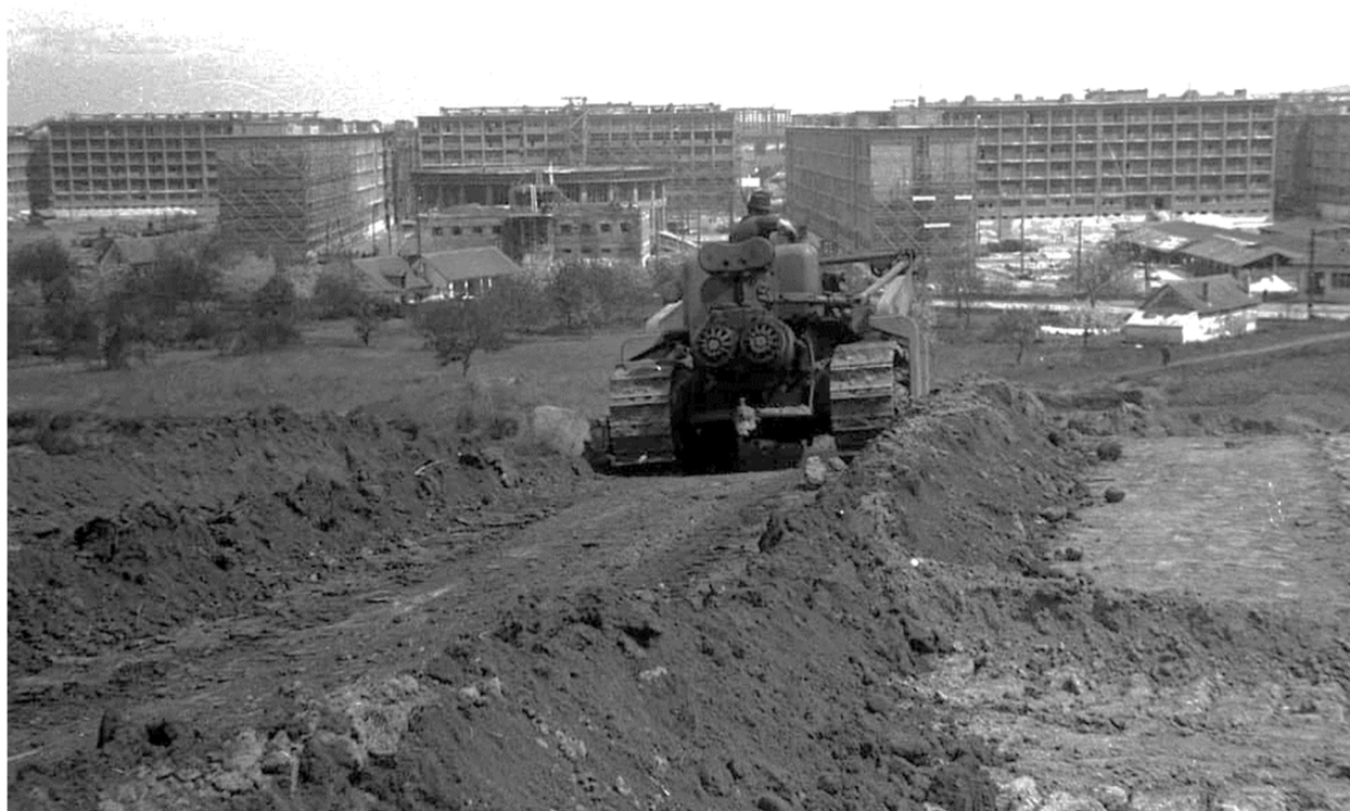
Slika 4. Pogled ka Studentskom gradu u izgradnji sa lokacije SRC „11. april“
