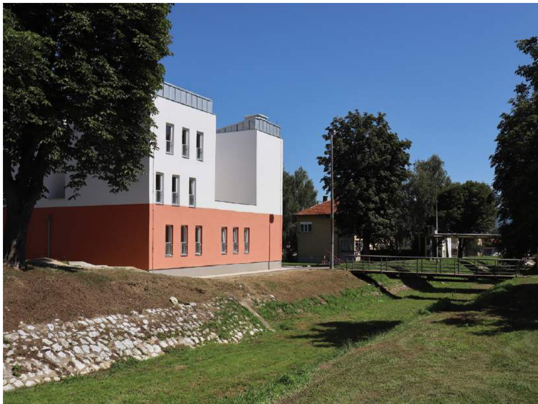
aa13 AUTORI_AUTHORS mr Zoran Abadić, Jelena Bogosavljević SARADNICI_COLLABORATORS Dušan Milovanović NAZIV_DELA_PROJECT TITLE Višeporodični stambeni objekat za izbeglice i raseljena lica // The Regional Housing Programme – Residential Building for Refugees and Displaced Persons LOKACIJA_DELA_PROJECT LOCATION Sevojno, Srbija // Sevojno, Serbia GODINA_PROJEKTOVANJA_YEAR OF DESIGN 2017 GODINA_REALIZACIJE_YEAR OF REALIZATION 2020
