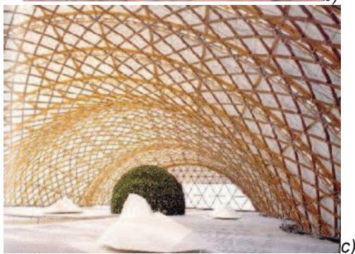
Slika 3 - Primena bambusa, plute, kartona i papira na arhitektonskim objektima: a) Bambus kao fasadna obloga, Garaža – Zoo Parking garage, Leipzig, Germany, HPP Hentrich–Petschnigg & Partner KG – arhitektonski tim, 2004. godine [8], b) Pluta kao fasadna obloga, Portugalski paviljon, EXPO 2000, Hanover, Nemačka, arhitekta Alvaro Siza, 2000. godine [9], c) Paviljon sa primarnom konstrukcijom od kartona i krovnim pokrivačem od papira, Japanski paviljon, EXPO 2000, Hanover, Nemačka, arhitekta Shigeru Ban, 2000. godine [10]
