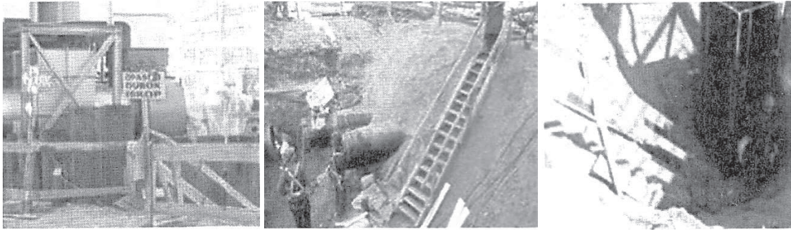
Слике 17,18,19. Приказ безбедних ситуација приликом машинског ископа
