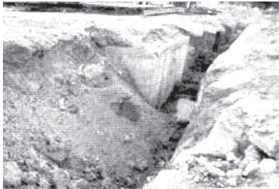
Слике 2,3,4,5. Приказ небезбедних ситуације на земљаним радовима дубине преко 1м
