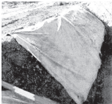
Слике 6,7. Приказ безбедне ситуације приликом машинског ископа (постављање оплате)
