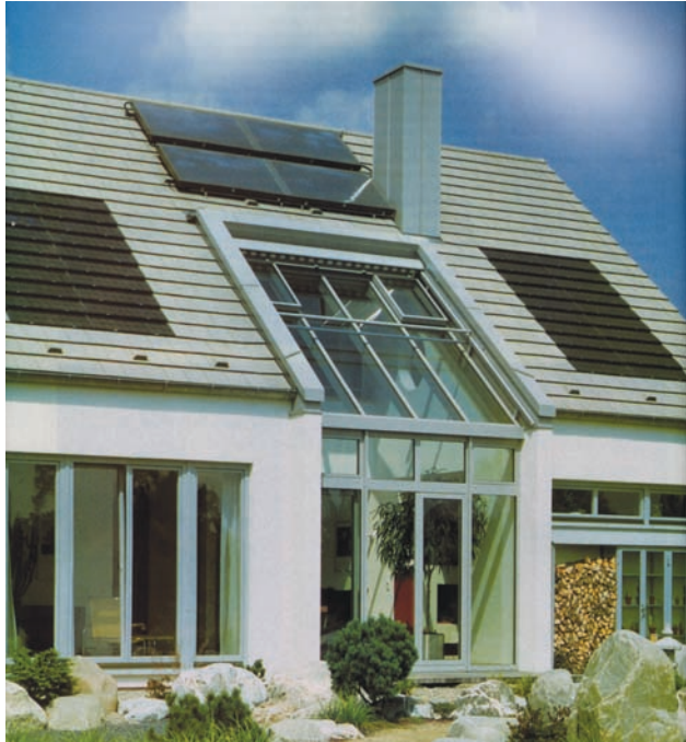
Сл. 1. Мултифункционалан кров са аутономним соларним колекторима за топлу воду, интегрисаним ФЕ цреповима за производњу електричне енергије и стаклеником за индиректно загревање простора [6]
