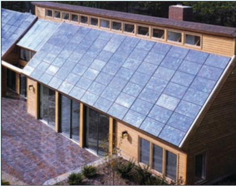
Сл. 8. Интегрисани ФЕ модули [21] Fig. 8 Building integrated PV modules [21]
