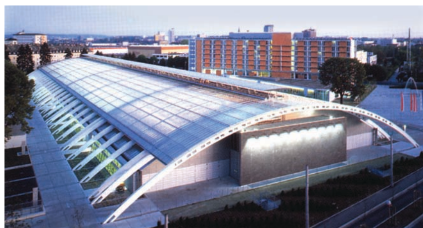
Сл.18. Кровно застакљење са микро-растером од танких жалузина у функцији сенила, Congress and Exhibition Hall, Linz, Аустрија [7] Fig. 18. Roof glazing with thin louvre grids as shading device, Congress and Exhibition Hall, Linz, Austria [7]
