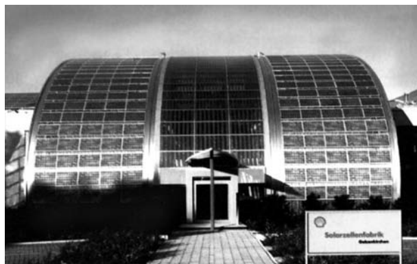
Сл. 11. Лучни кров са ФЕ модулима од поликристалног Si производи 10-12MW годишње, Shell, Gelsenkirchen, Немачка Fig. 11. Arched roof with PV modules of poly-crystalline Si annually produces 10-12MW, Shell, Gelsenkirchen, Germany
