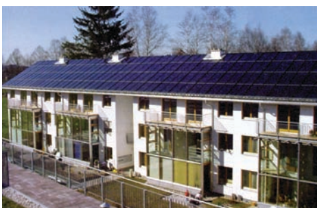
Сл. 2. Кровови са соларним колекторима за загревање воде и станова, Немачка а) аутономни [7] и б) интегрисани колектори
