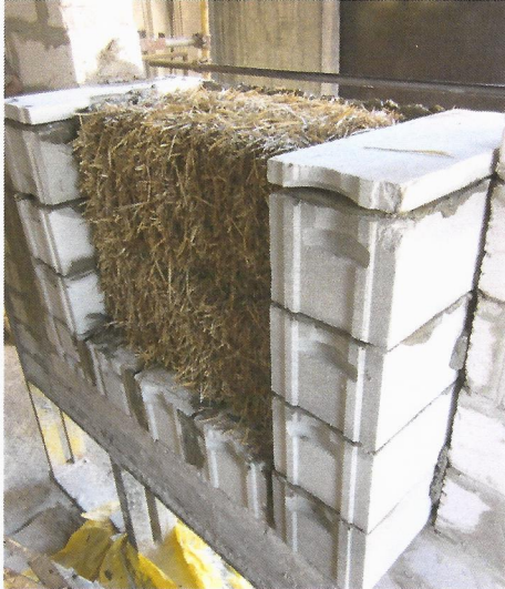
Snimak 1 – Ugradnja uzorka – pogled iz peći
