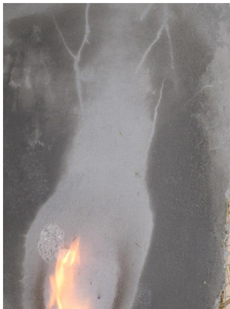
5.4.3.8. 40', појављују се пукотине на крају зида
