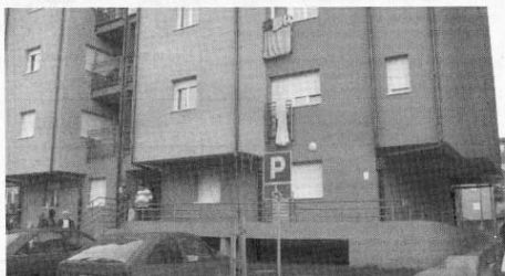
Nema novca za kupovinu preparata: Naselje Kamendin
