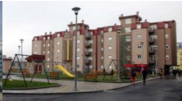
Слика 59: Тип II-B, социјално рентално становање у Ул. Акробате Алексића, Насеље Камендин 1.6, Земун поље, Општина Земун
