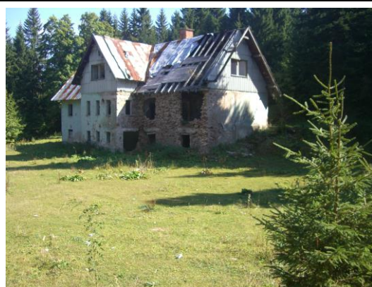
Сл.241 Постојеће стање објекта (Пројекат реконструкције старе војне пекарне на Јахорини у апартманско насеље, извор: аутор)
