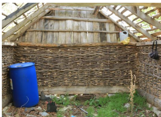
Сл.174 Стаја у изградњи, Обод кањона реке Увац, Рашка област, (извор: аутор)
