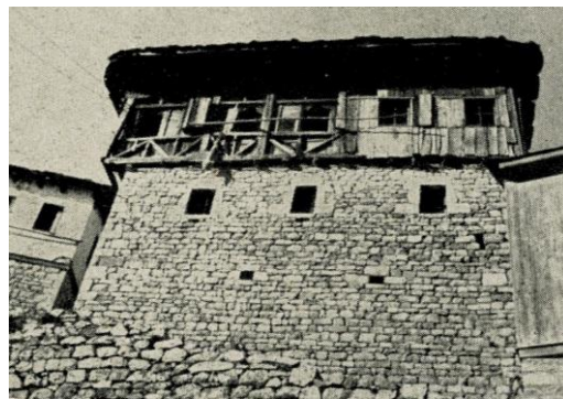
Сл.167 Стамбена зграда из северозападне Македоније (Tomoski, S.: Makedonska narodna arhitektura i njena primjena u modernoj arhitekturi , Arhitektura, br 13-17, Zagreb, 1948, с.73-90)
