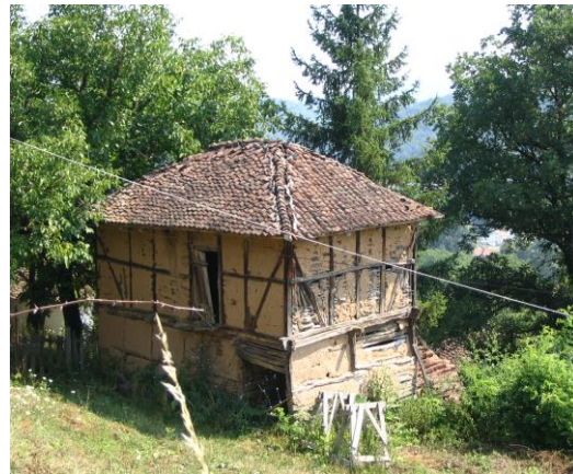
Сл.123 Бондручна конструкција са кровом од ћерамиде, околина Медвеђе (извор:аутор)
