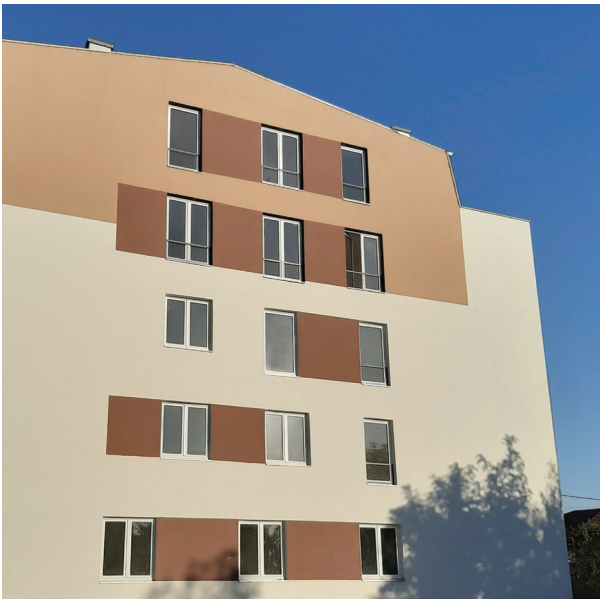
Сл. 9-10. Детаљи фасада изведеног објекта (фото: И. Марић, новембар, 2019.)
