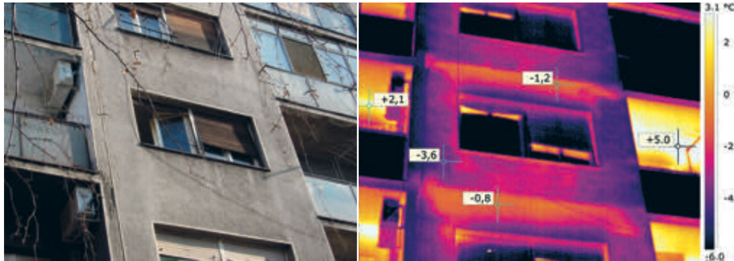
Сегмент фасаде 1 – Сегмент термички неизоловане фасаде Façade segment 1 – Segment of thermally non- insulated façade
