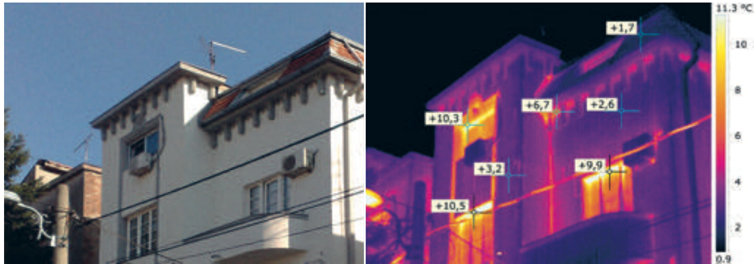
Сегмент фасаде 1 – Обновљена и термоизолирана улична фасада Façade segment 1 – Refurbished and thermally insulated street facade
