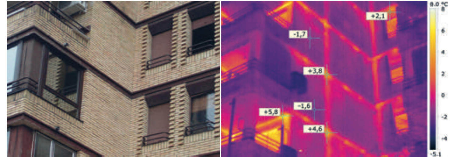
Сегмент фасаде 2 – Сегмент вишеслојне термички изоловане фасаде Façade segment 2 – Segment of multilayered thermally insulated façade
