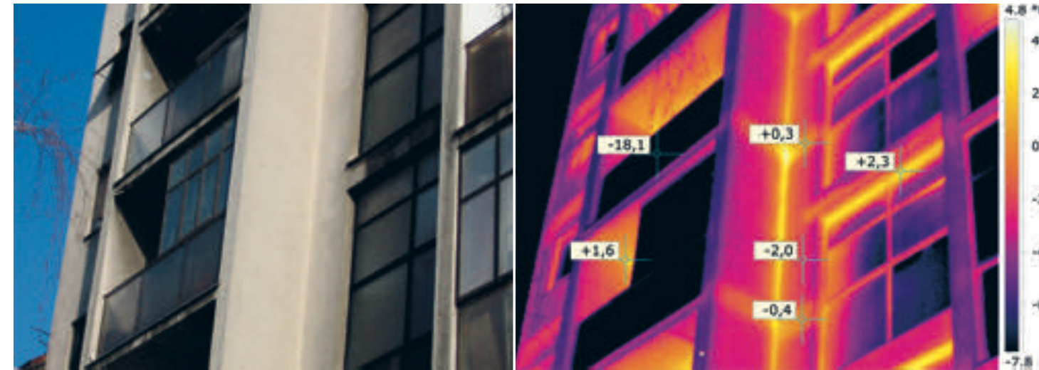
Сегмент фасаде 2 – Сегмент термички неизоловане фасаде Façade segment 2 – Segment of thermally non- insulated façade
