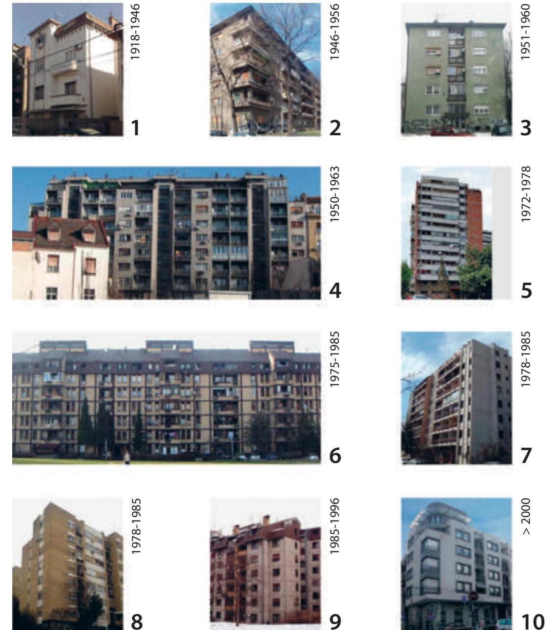
Слика 1 – Одабране зграде — Figure 1 – Selected buildings
