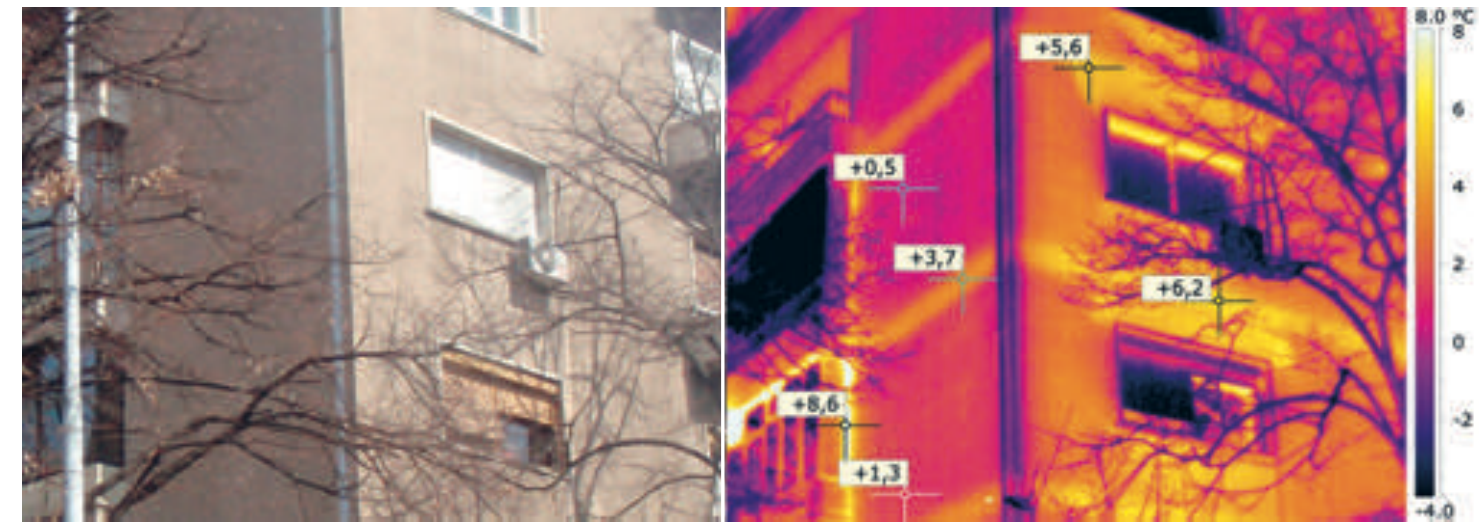
Сегмент фасаде 2 – Сегмент оригиналне термички неизоловане фасаде Façade segment 2 – Original segment of thermally non- insulated façade
