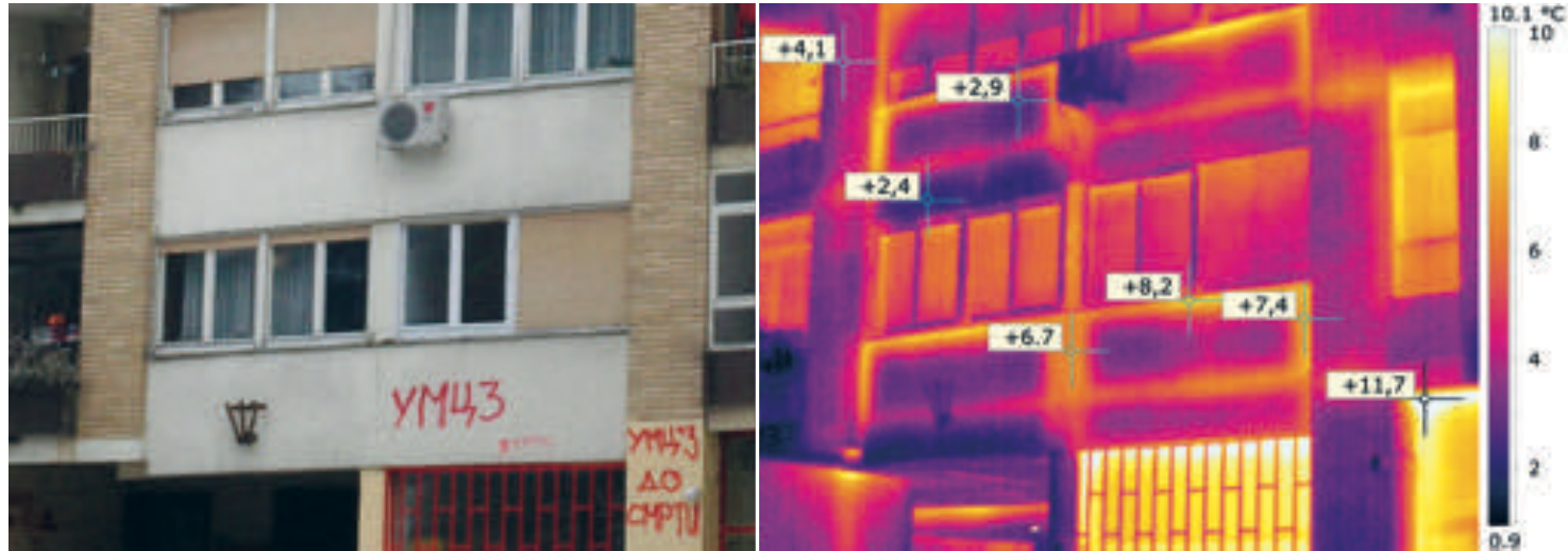
Сегмент фасаде 1 – Сегмент вишеслојне термички изоловане фасаде Façade segment 1 – Segment of multilayered thermally insulated façade
