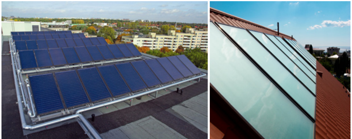
Слика 10. Соларни термални колектори на равном и косом крову
