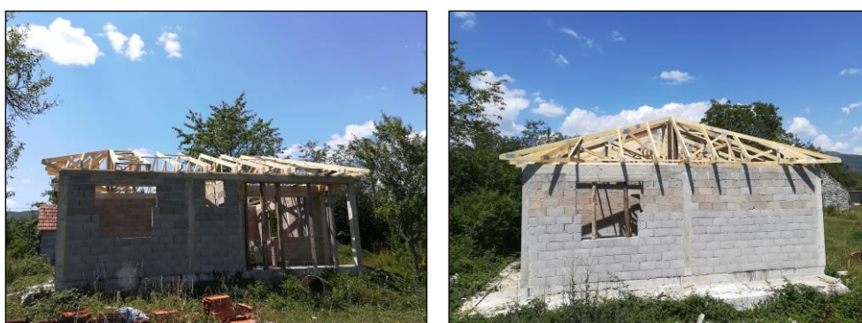
Slika 4. Realizovana krovna konstrukcija
