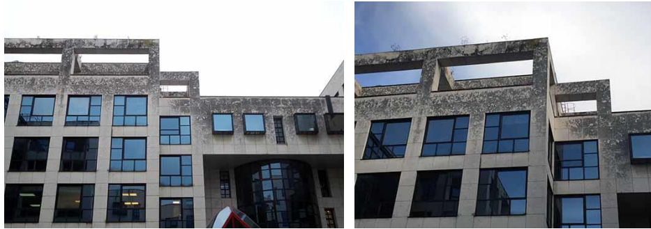
Slika 1. Telekom Srbija, poslovna zgrada, autor arhitekt Mario Jobst (fotografije Milan Radojević)
