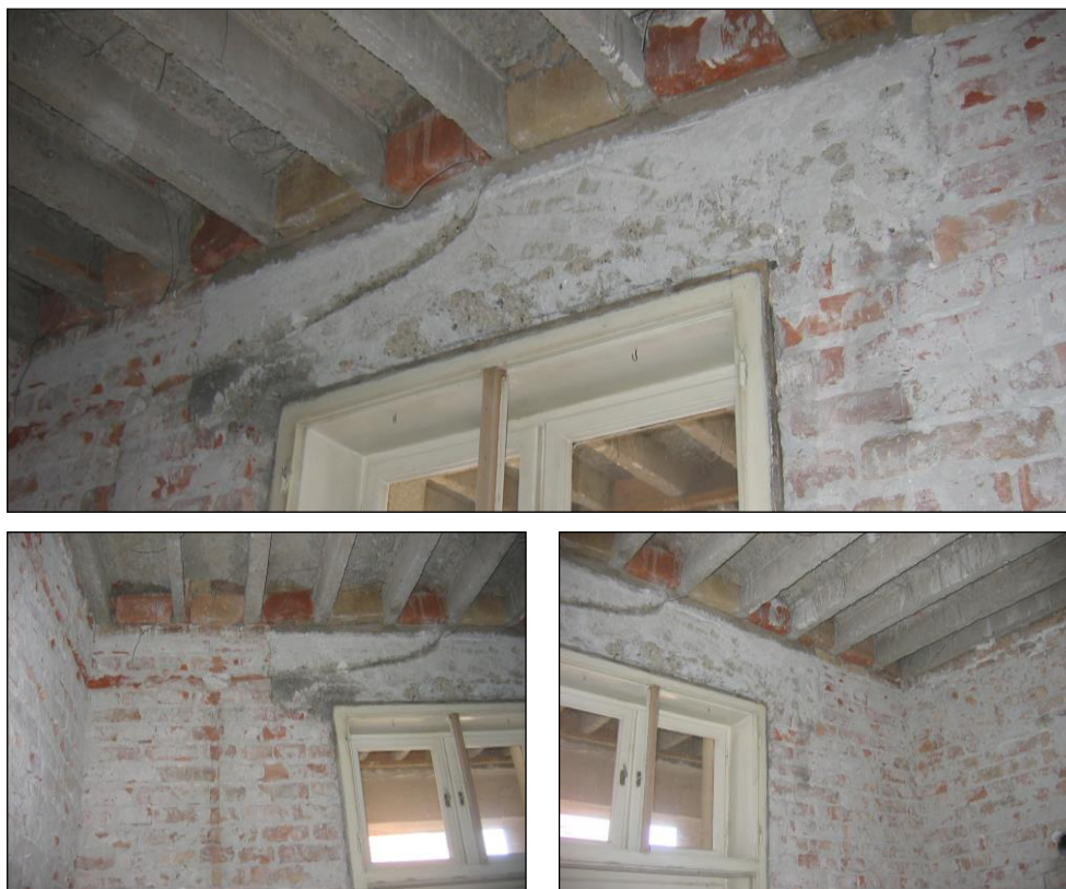
Slika 1. Izgled nosivog zidanog zida (pogled iz sobe) - postojeće stanje
