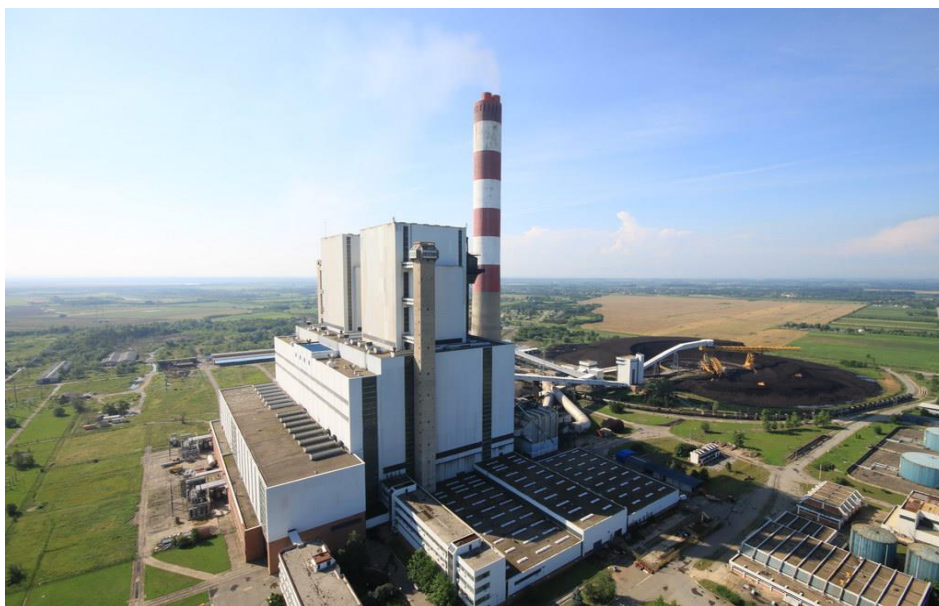
Slika 4. Termoelektrana „Nikola Tesla – B“ (TENT-B) [10]
