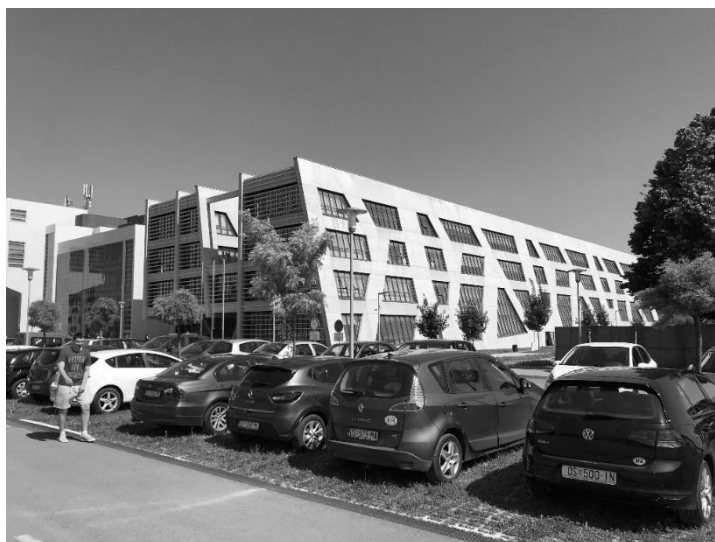
Slika 1. Zgrada Građevinskog fakulteta u sijeku
