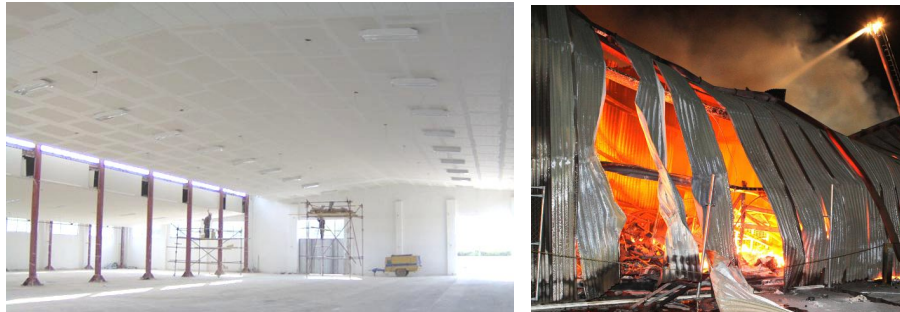
Slika 7 9 . Primeri: a) Hala sa spuštenim plafonima i b) PU fasadni paneli u požaru
