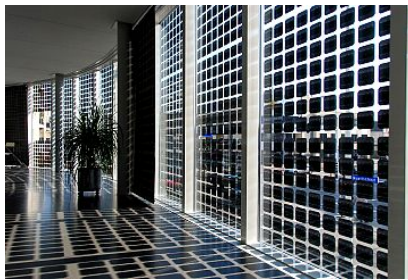
Slika 1. Polutransparentni fasadni moduli sa razmaknutim ćelijama
