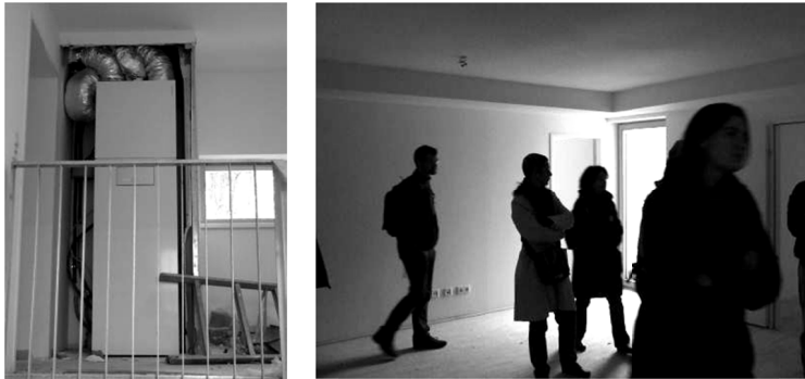
Slike 2 i 3. Kompaktna jedinica i razvod ventilacije u stambenoj kući u Beču (izvor: autor)
