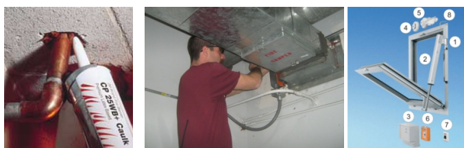
Slika 19. a) Injektiranje zaptivne paste mase; b) provera klapne, c) specijalni ventus prozor za odimljavanje
