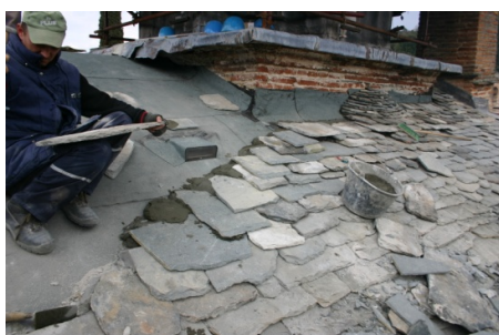
Slika 4. Postavljanje kamenog krovnog pokrivača
