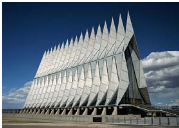
Slika 1. Primena naboraste konstrukcije kao krovne konstrukcije [1]: a. objekat kapele u Vazduhoplovnoj akademiji, Colorado Springs, USA, 1962., b. Međunarodni kongresni i izložbeni centar, Nanning, Kina, 2003.
