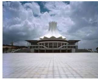
Slika 1. Primena naboraste konstrukcije kao krovne konstrukcije [1]: a. objekat kapele u Vazduhoplovnoj akademiji, Colorado Springs, USA, 1962., b. Međunarodni kongresni i izložbeni centar, Nanning, Kina, 2003.
