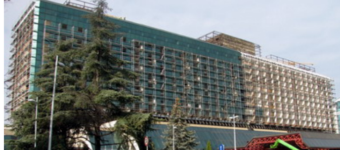
Slika 5. Potpuna zamena postojeće staklene fasade novom staklenom fasadom, modernizacija na hotelu Crown Plaza, ex-Kontinental, Beograd, 2013. ( www.beobild.rs )
