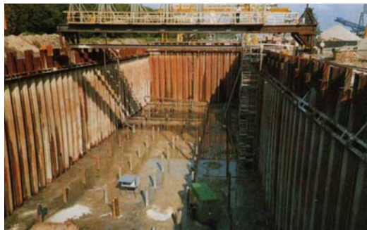
Slika 5. Obezbeđenje temeljne jame Larsen talpama [9]
