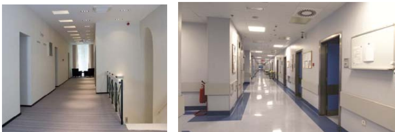
Slika 11. Hodnik hotela bez požarnog izdvajanja od stepeništa sa gorivim podnim pokrivačem; Desno: Hodnik u Urgentnom centru Novi Sad – širok za lako mimoilaženje kreveta; plastični podovi koji se lako održavaju ali obično gorivi (ne tako lako zapaljivi i brzo gorivi ali ipak gorivi); veće opasnosti su skrivene u spušenom plafonu gde se vode snopovi kablova
