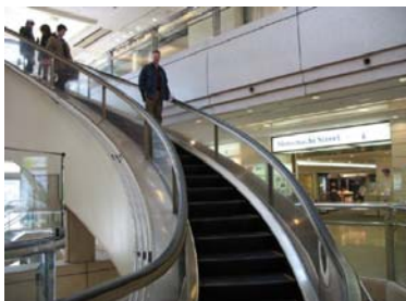
Slika 21. Primjenjuju se i zavojni eskalatori – prečnik unutrašnjeg cilindra je dovoljno veliki da se iskoristiti cela širina "spepenika" – a širina je obično veća od 91 cm tako da je moguće mimoilaženje /preticanje/. Desno: Izolovanje niže etaže od gorenje negorivim zavesama – jedno od rešenje za sprečavanje prodora vatre i dima kad se traži da se razdvoje kao dva požarna sektor
