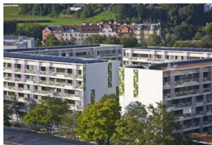
Slika 6: Solarni paneli na krovu
