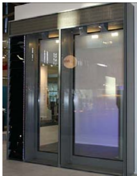
Slika 9 i 10. TeMotion Wicona, aktivna element fasada, posebno pogodna za modernizaciju visokih objekata visokih performansi, integriše više aktivnih sistema (www.wicona.de)
