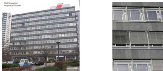
Slika 11. Mogućnost modernizacije fasade sa pojedinačnim prozorima ili prozorskim trakama, objekat Dgb Haus Dusseldorf ( www.schuco.de )
