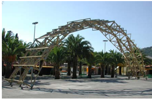
Slika 2. Montirani prototip cilindrične naboraste konstrukcije na sajmu u Budvi, u Crnoj Gori, autor Nenad Šekularac, arhitekta, 2005. [3]
