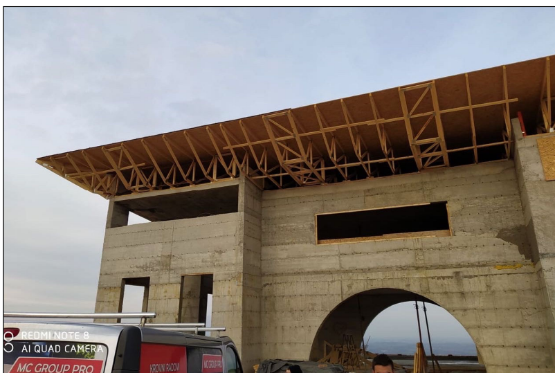
Slika 5. LKV konstrukcija u fazi montaže
