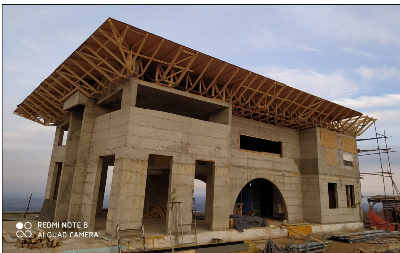
Slika 7. LKV konstrukcija u fazi montaže
