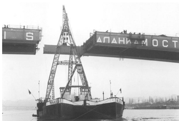
Gradilište (Arsić, 1997, str. 122; Izgradnja autoputa 1970, str. 34)
