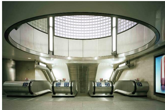
Slika 113 i 114. Različiti načini uvođenja prirodnog osvetljenja u unutrašnji prostor metro stanice: Canary Wharf Station, London (Norman Foster) (levo) i Southwark Station, Jubilee line, London (desno)
