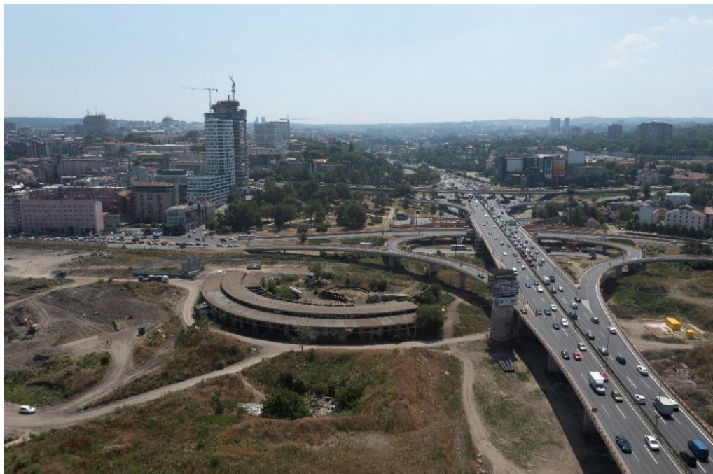
Pogled preko starog objekta Ložionice na Savsku ulicu i park Gazela
