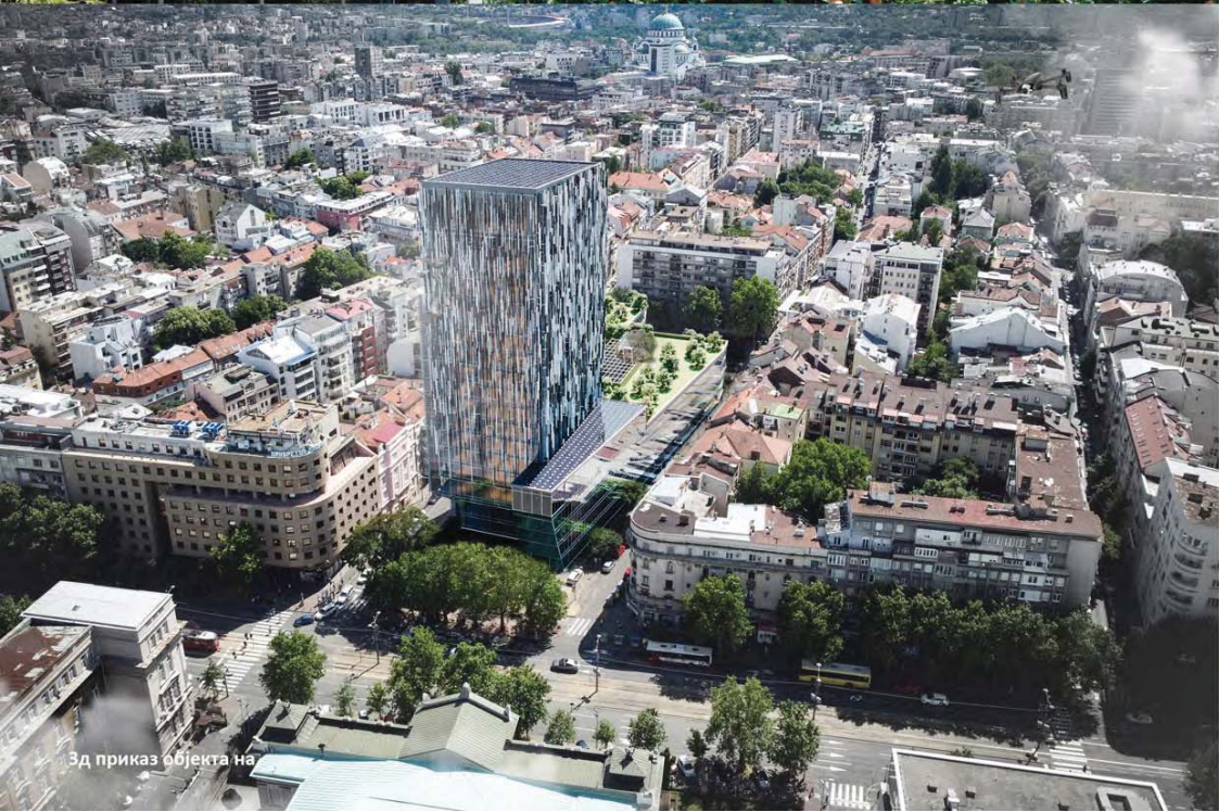
3д приказ фасаде солитера
