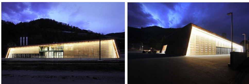
Слика 110: Роланд Балди (Roland Baldi), District heating plant , Клаусен, Италија, 2007. Извор: http://www.archilovers.com/projects/107091/district-heating-plant-in-chiusa.html
