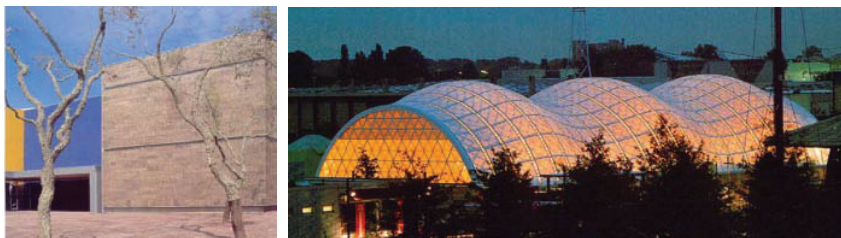
Slika 4. Primena plute, papira i kartona na arhitektonskim objektima: a. Pluta kao fasadna obloga - Portugalski paviljon, EXPO 2000, Hanover, Nemačka [9], b. Paviljon sa primarnom konstrukcijom od kartona i krovnim pokrivačem od papira, Japanski paviljon, EXPO 2000, Hanover [10]
