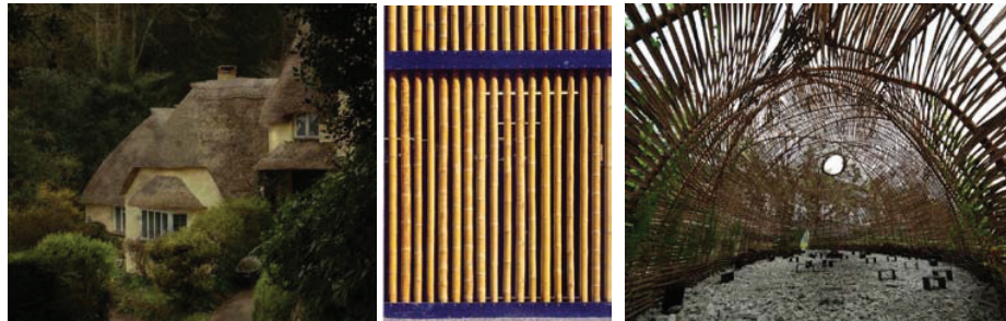
Slika 3. Primena trske i bambusa u arhitekturi: a. Kuća pokrivena trskom, b. Bambus kao fasadna obloga – Garaža: Zoo Parking garage, Leipzig, Germany [7] , c. Paviljon od bambusa - Cicada, Taipei City, Taiwan [8]
