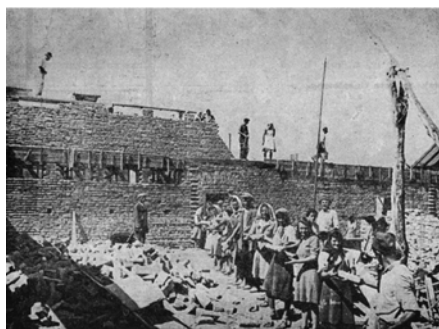
Figure 6. Peasants on construction site, Novi Vrbas, Vojvodina, 1948. Učešće sekcije arhitekata Beograda DIT-a NR Srbije u akciji izgradnje zadrudnih domova (1949) Tehnika, No. 2-3, p. 97.
