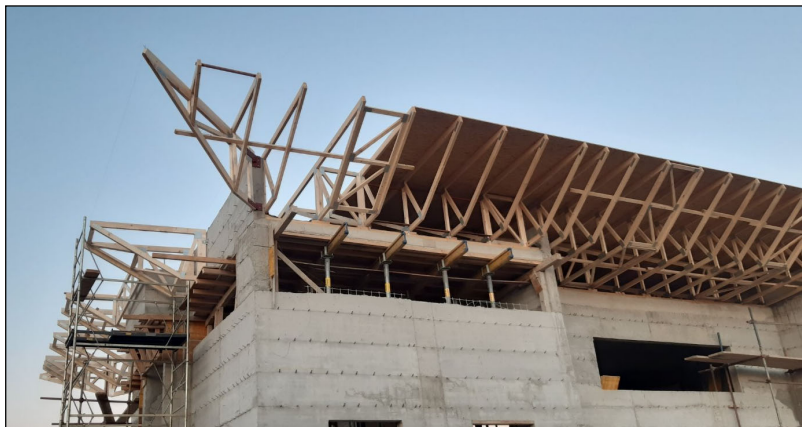
Slika 4. LKV konstrukcija u fazi montaže
