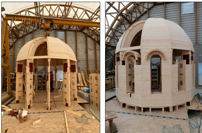
Slika 5. Konstrukcija krova u fazi izrade u proizvodnom pogonu
