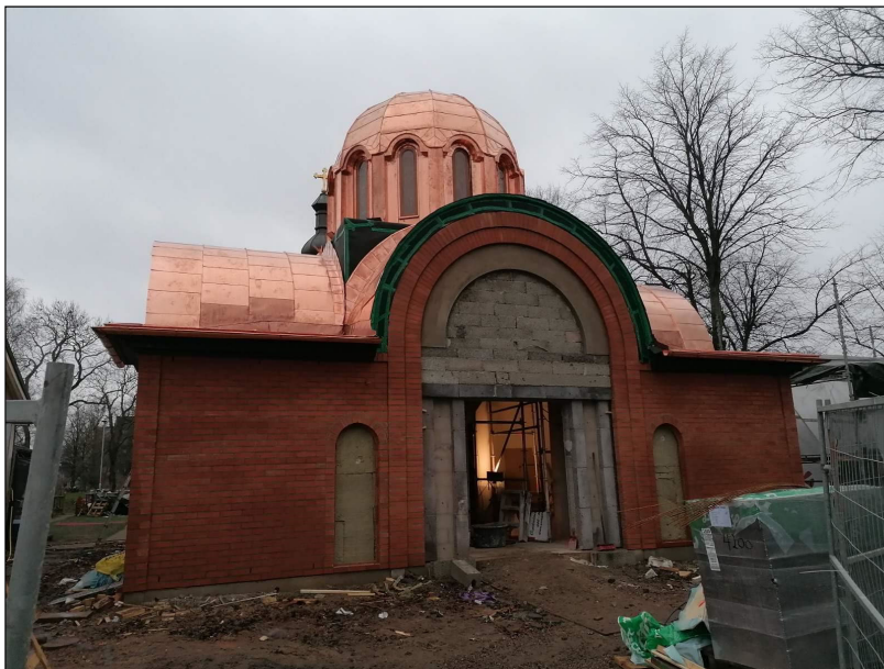
Slika 7. Konstrukcija krova nakon montaže
