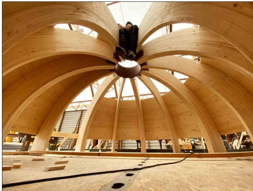
Slika 4. Konstrukcija krova u fazi izrade u proizvodnom pogonu
