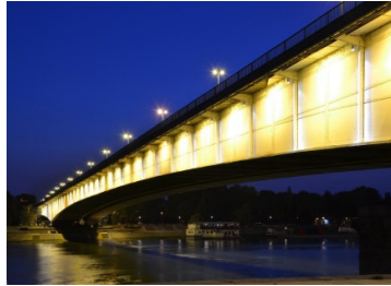
Slika 4. Izgled prethodne instalacije dekorativnog osvetljenja Brankovog mosta
