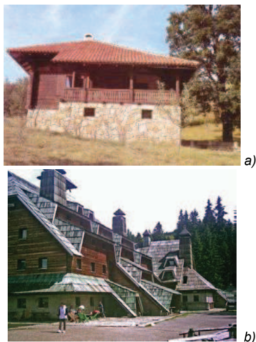
Slika 2 - Kombinacija kamena i drveta kao fasadne obloge: a) Kuća za odmor, selo Dići, Ljig, arhitekta Božidar Petrović [7], b) Planinarski dom „Rtanj”, arhitekta M. Đorđević, Kopaonik [8]
