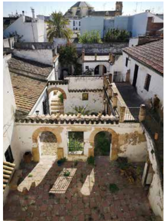
Figure 2. Imagen de la Casa PAX Astronautas antes de la obra
