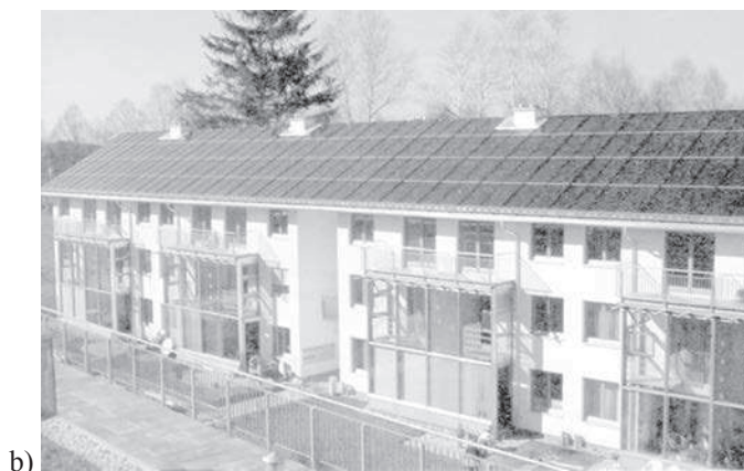
Slika 2. Toplotni prijemnici sunčeve energije a) autonomni (Hercog T. 1996) i b) integrisani
