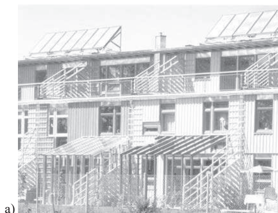
Slika 2. Toplotni prijemnici sunčeve energije a) autonomni (Hercog T. 1996) i b) integrisani
