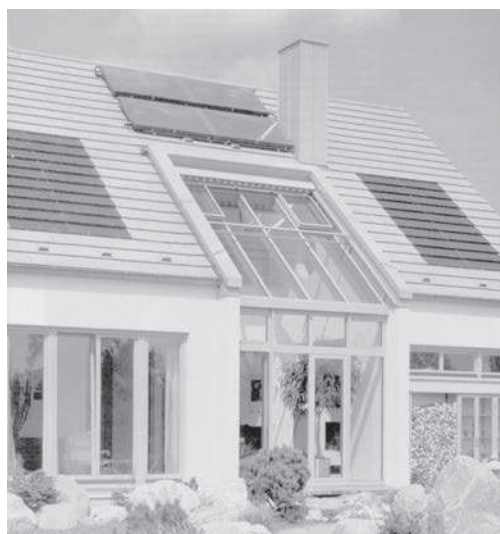
Slika 1. Multifunkcionalan krov sa autonomnim toplotnim prijemnicima sunčeve energije, integrisanim FE crepovima i staklenikom za indirektno zagrevanje prostora (Hänel A.2000)
