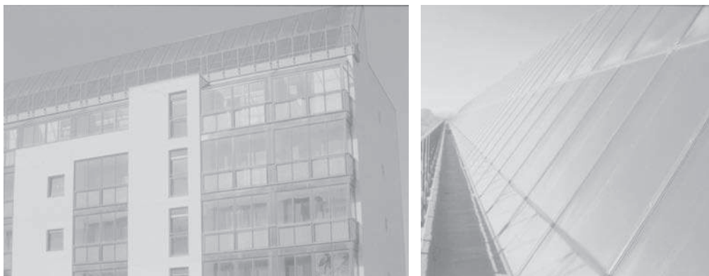
Slika 5. Oluk omogućava pristup toplotnim prijemnicima u cilju njihovog održavanja
