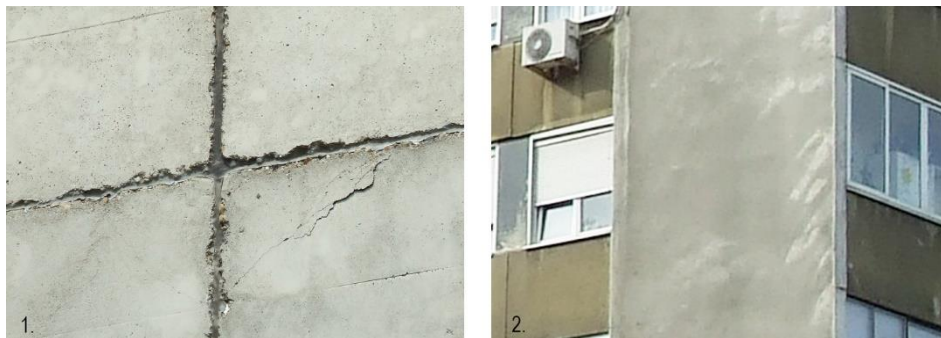
Слика 17. Пројектантска решења спојница код једноетажних префабрикованих панела: 1. – видне и 2. - скривене (прекривене) спојнице (Фотографије аутора)
