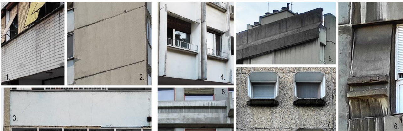
Слика 14. Прикази фасадних елемената са различитим геометријским карактеристикама: а) једноставне геометрије – 1., 2. и 3.; б) сложене геометрије – 4., 5., 6., 7. и 8. (Фотографије аутора)
