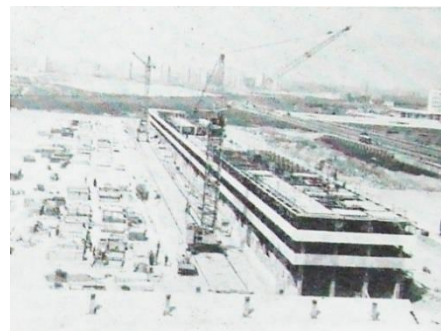
Слика 85. Изградња објекта 21/В-8 (Simić, 1978)
