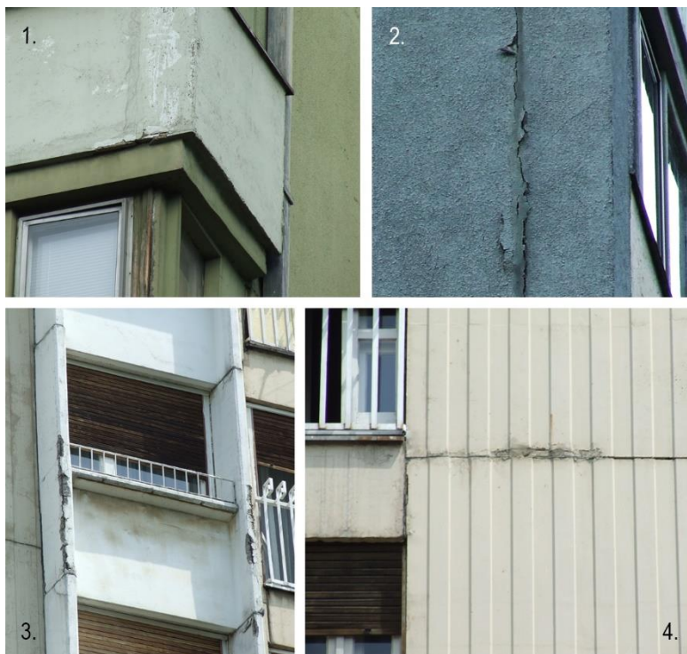
Слика 30. Различити начини финализације површина префабрикованих елемената: 1. фасадним премазима третирани префабриковани елементи са завршним обрадама мање храпавости, 2. фасадним премазима третирани префабриковани елементи са завршним обрадама веће храпавости, 3. елементи третирани премазима од белог „фасадекса“ и 4. премазима од гранулата белог млевеног мермера и белог цемента прекривени фасадни елементи (Фотографије аутора)
