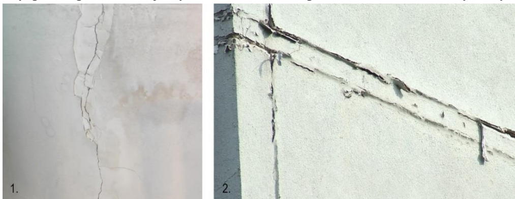
Слика 48. Прикази: 1. пукотине у ентеријеру у зони вертикалне (затворене) спојнице између парапетних панела – спојница је у потпуности изведена од армираног бетона, без присуства трајноеластичних маса у спољашњој зони спојнице и 2. оштећења у зони хоризонталних и вертикалних спојница у екстеријеру (Фотографије аутора)
