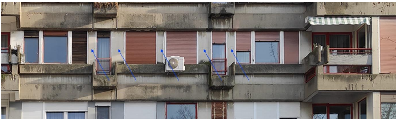
Слика 18. Плоче на бази цемента различитих димензија (означене стрелицама) фиксиране у између прозора, пример на згради 23/7 у блоку 23 (Фотографија аутора)
