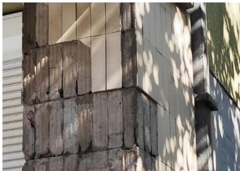
Слика 52. Пример отпалих керамичких плочица као облога префабрикованог армиранобетонског стуба у случају примењене технике накнадног постављања плочица у слоју цементног малтера (Фотографија аутора)
