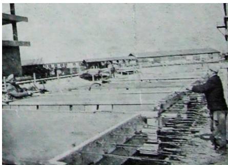
Слика 84. Производња сегмената ТМ-3 таваница на градилишту у блоку 21 (Simić, 1978)
