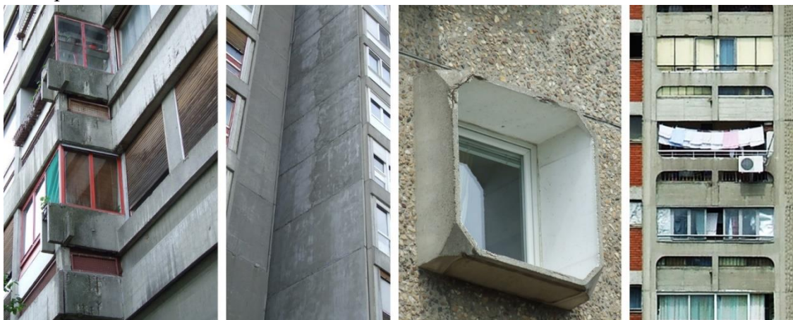
Слика 40. Примери префабрикованих фасадних елемената изведених у техници видног бетона са одразом оплате са равним површинама (Фотографије аутора)
