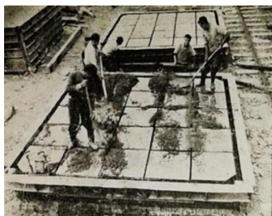
Слика 73. Процес израде касетиране таванице (Petrović, 1964)
