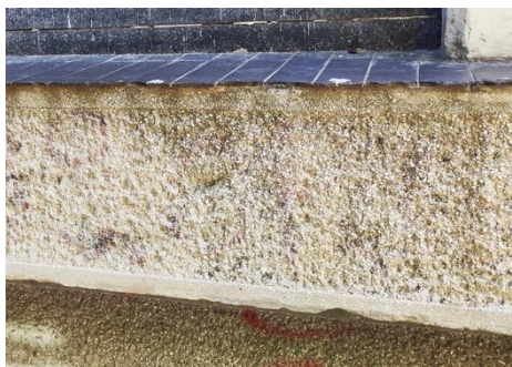
Слика 32. Приказ облагања вештачким пикованим каменом ивичног армиранобетонског префабрикованог носача у зони сокле (Фотографија аутора)
