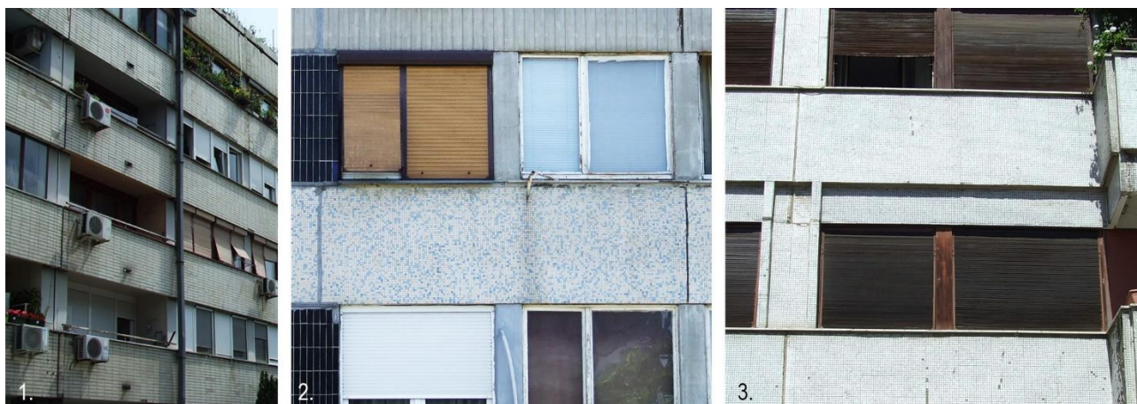
Слика 35. Приказ: 1. примењене правоугаоне керамичке плочице на фасади зграде 21/7-А; 2. мозаик плочице као облоге парапета зграде 21/В-8 и 3. мозаик плочице (стаклене) као облоге парапета и међупрозорских елемената у склопу фасада свих зграда у блоку 29 (Фотографије аутора)
