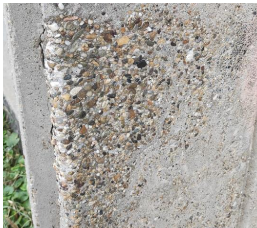
Слика 55. Пример еродиране површине армиранобетонског носећег фасадног зида који је ливен на лицу места (Фотографија аутора)
