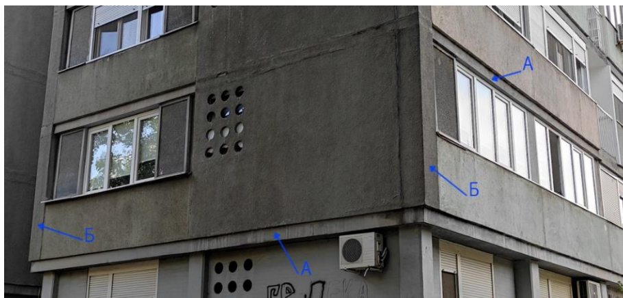
Слика 20. Пример (зграда тип 1,2/С, блок 1) где је заступљен случај примене хоризонталних носећих линијских елемената (А) и вертикалних носених линијских елемената (Б) (елементи скривају на спратним етажама зоне стубова, који су видни у зони приземља – доња зона фотографије) (Фотографија аутора)
