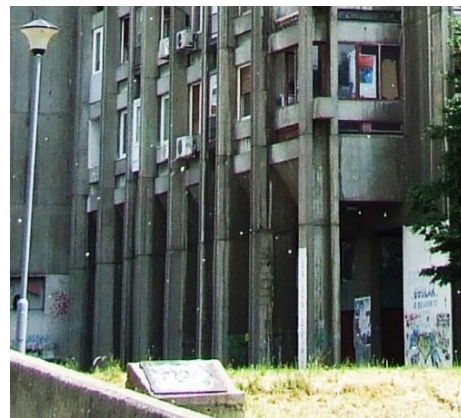
Слика 101. Решење колонаде у зони приземља (Фотографија аутора)
