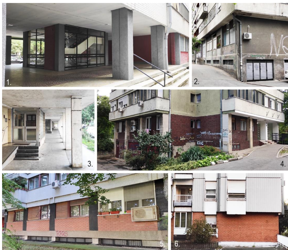
Слика 44. Примери материјализације фасада у зонама приземља зграда: 1. 21/7-А, 2. 1,2/А, 3. 21/В-8, 4. 1,2/Д, 5. 29/4 и 6. 30/11 (Фотографије аутора)
