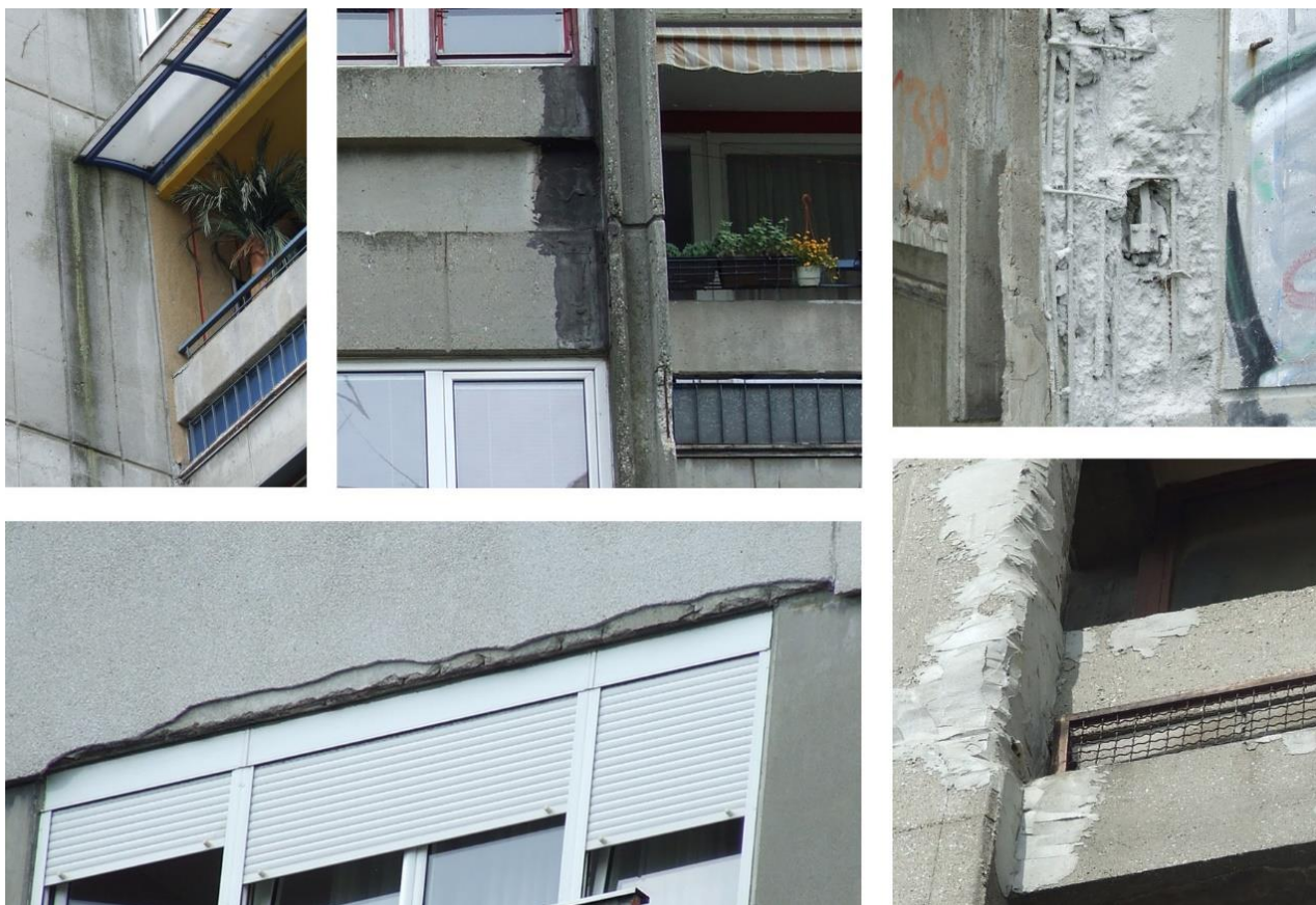
Слика 56. Примери нестручних интервенција на површинама фасадних склопова и њихови резултати (Фотографије аутора)
