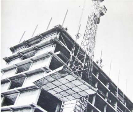
Слика 74. Процес вертикалног транспорта касетиране таванице (Martinović et. al, 1961)
