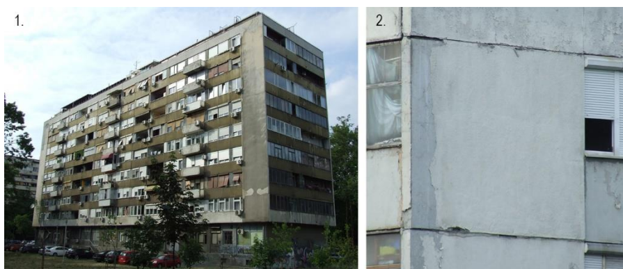
Слика 31. Приказ крајњих бочних фасадних површина (вертикалних) подужних фасада: 1. фасадне површине прекривене племенитим малтером које одају утисак монолитних целина и 2. фасадне равни прекривене племенитим малтерима са видним (наглашеним) спојницама (Фотографије аутора)
