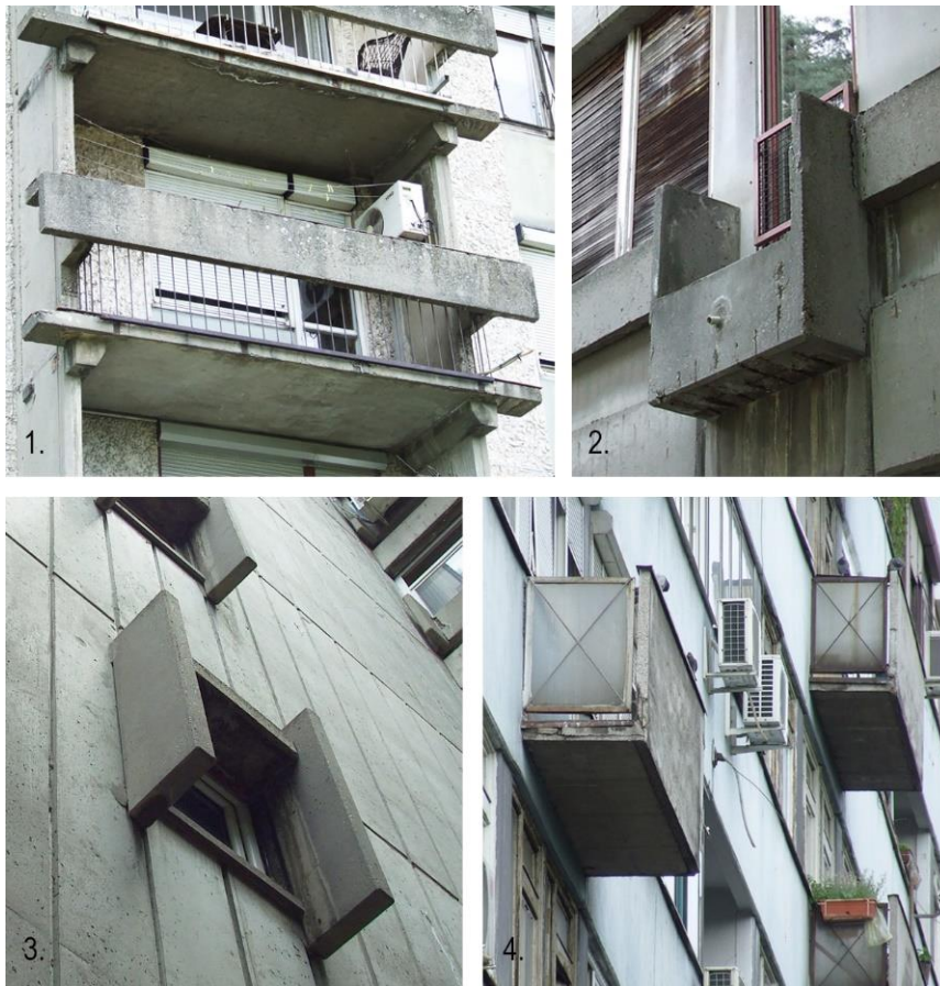
Слика 21. Примери разних префабрикованих елемената: 1. елемент ограде - блок 28; 2. жардињера – блок 23; 3. прозорска сенила – блок 22 и 4. терасе – блок 2 (Фотографије аутора)
