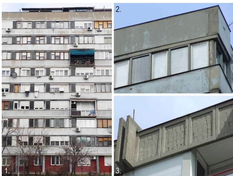
Слика 47. Примери оштећења – деградације (нестајање) финалних слојева у зонама назидака: 1. видна разлика у степену оштећења на фасади од приземља према зони равног крова; 2. непостојање фасадних премаза на површини назидака и 3. оштећени заштитни слојеви арматуре у бетонима назидка (Фотографије аутора)
