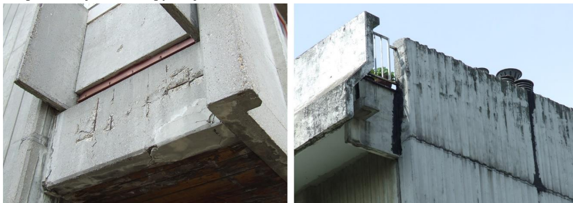
Слика 46. Примери оштећења услед присуства атмосферских утицаја (Фотографије аутора)
