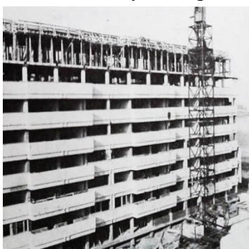
Слика 93. Приказ изградње конструкције ливене на лицу места у зони повученог спрата (Vučić, 1970)
