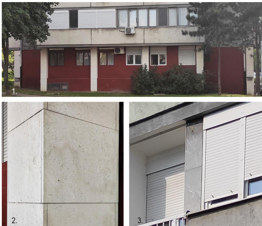
Слика 36. Примери облагања стубова каменим плочама: 1. приказ решења приземља; 2. детаљ начина постављања камених плоча и 3. облагање стубова у зони прозора и врата (Фотографије аутора)
