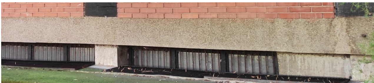
Слика 38. Решење облагања фасаде применом кулије бетона у зони сокле у блоку 29 (Фотографија аутора)
