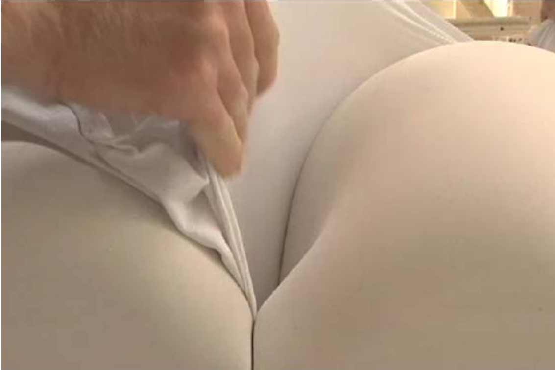
Слика 1.5.3.2 Уклањање флексибилне оплате. Прототипски модел „Wall P“, Andrew Kudless 2006-09. Кадар из филма у продукцији SFMoMA 2009. поводом изложбе „Sensate Bodies and Design“.
