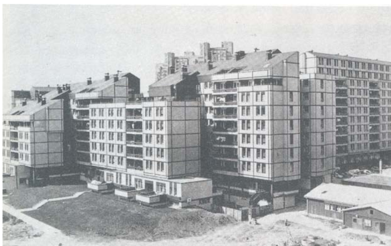
Слика 17. Блок 19а Нови Београд (Изградња, 11/12/1983: 35)
