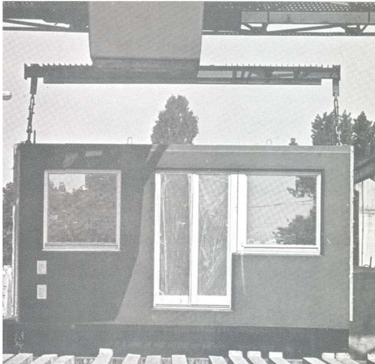
Слика 40. Систем Рад-Баланси монтажа фасаде (Изградња: 2/1980:34)
