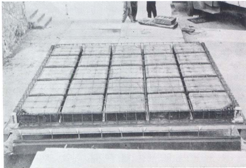
Слика 31. Метални калупи за ИМС таваницу (ИМС, 1968: 230)
