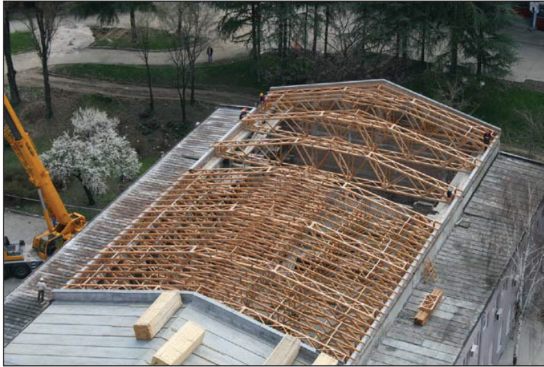
Slika 8. Formiranje krovne drvene strukture
