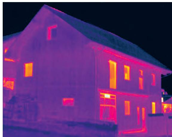
Породична кућа са масивним зидовима од опеке и фасадом изведеном у виду „контактне“ термоизолације фасаде. На термограму се уочава нижа температура зида негрејаног тавана као и губици топлоте на местима продора конзолних тераса кроз термички омотач, односно у зони стрехе. Конструкција прозора и улазних врата је неодговарајућа са приметним топлотним губицима.
