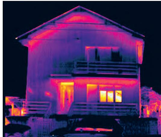
Породична кућа са масивним зидовима од опеке и фасадом накнадно изведеном у виду „контактне“ термоизоловане фасаде коришћењем полистиренских блокова. На термограму се уочавају губици топлоте на местима продора конзулних тераса кроз термички омотач и у зони стрехе. Конструкција прозора и улазних врата је неодговарајућа са приметним топлотним губицима.
