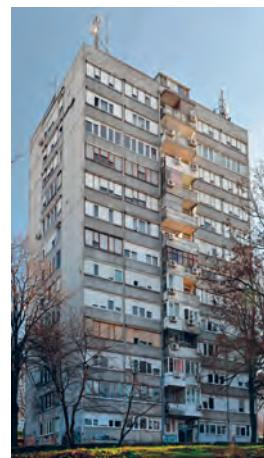
Стамбени солитер са пуним фасадним зидовима од бетона или шљако блокова без термоизолације и тракама лаких парапетних зидова и прозора. Термограм приказује приметне губитке топлоте кроз бочне масивне зидове нарочито у зонама серклажа и на спојевима парапетних зидова и прозора. Метална облога парапета услед високе рефлексивности карактерише се нереално ниским температурним очитавањима.
