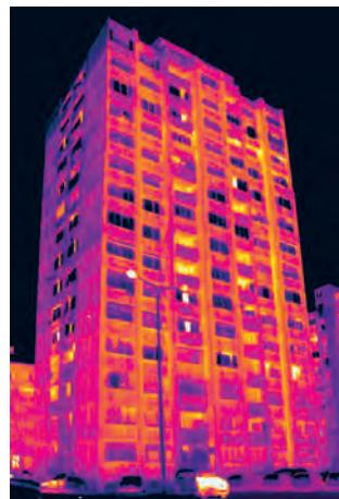
Стамбени солитер са фасадним зидовима од префабрикованих бетонских панела. Термограм приказује губитке топлоте на местима међусобних спојева панела као и у оквиру њихове структуре: везе носећег и завршног слоја, нарочито на парапетним елементима. Спојеви плоча тераса и фасадних зидова се карактеришу изразитим линијским губицима. Фасадна столарија лошег квалитета са приметним топлотним губицима.
