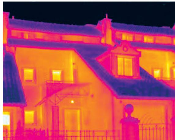
Породична кућа у низу са масивним фасадним зидовима од гитер блока, термоизолацијом и обзијдом од фасадне опеке. Кућа се греје у целости а на термограму може видети униформно понашање уз одсуство изразитих линијских губитака. Термичке перформансе зидова као и конструкција прозора и врата су у складу са, за то доба, важећим прописима из области топлотне заштите.
