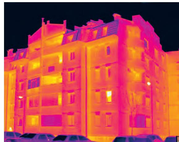
Стамбена ламела са масивним зидовима типа сендвич конструкције и завршним слојем малтера. На термограму се уочава одсуство изразитих зона топлотних губитака осим на спојевима плоча тераса и фасадних зидова, столарији и делимично на плочама еркера. Могуће је приметити слог фасадног зида као и хладније, линијске, зоне настале услед додатног изоловања хоризонталних серклажа и натпорзорних греда.
