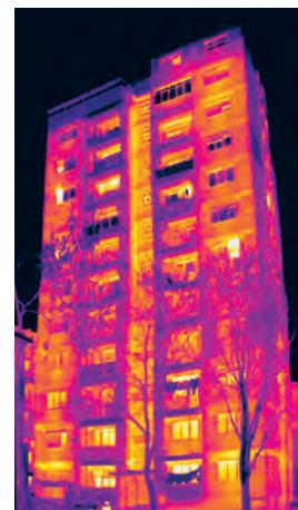
Стамбени солитер са масивним фасадним зидовима од Дурисол блокова без термоизолације. Термограм приказује приметне губитке топлоте кроз фасадни зид нарочито у зонама хоризонталних и вертикалних армирано бетонских серклажа. Изражени губици топлоте на парапетним зидовима те је могуће уочити положај грејних тела (радијатора). Оригинална фасадна столарија је у лошем стању уз знатне губитке топлоте.
