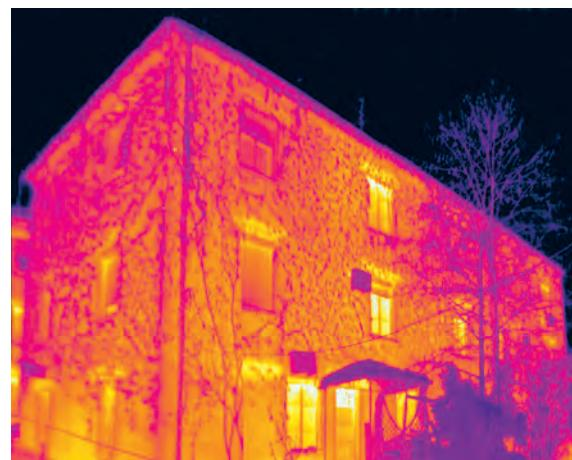
Стамбена ламела са изразито масивним фасадним зидовима од опеке без термоизолације. Термограм приказује равномерне губитке топлоте кроз фасадне зидове са повећаним интензитетом у зони натпрозорних греда (и код зазиданог отвора приземља). Појединачни прозори су замењени савременим од ПВЦ профила и добрих су термичких карактеристика док се оригинални карактеришу изразитим топлотним губицима.
