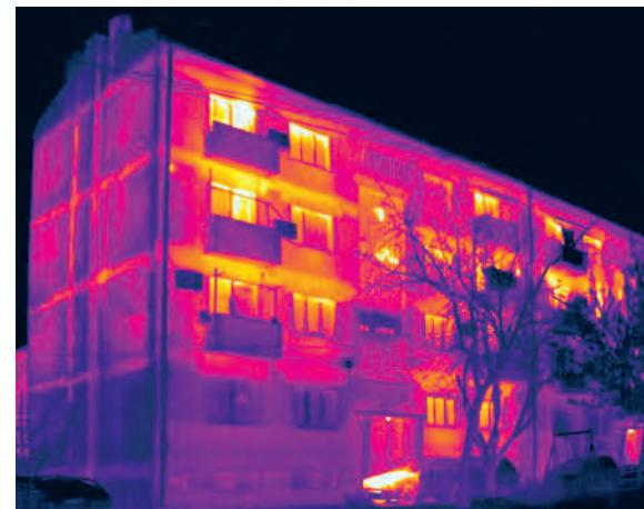
Стамбена ламела са масивним фасадним зидовима од опеке без термоизолације. Термограм приказује различите интензитетите губитака топлоте кроз фасадне зидове на местима армирано бетонских серклажа и зидане испуне. Такође је уочљива разлика између негрејаног простора тавана односно стана у приземљу и осталог, грејаног дела зграде. Фасада на столарија се карактерише изразитим губицима топлоте.
