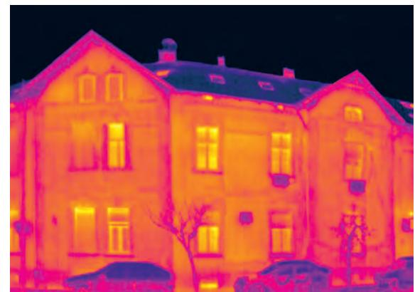
Стамбена ламела са изразито масивним, хомогеним, фасадним зидовима од опеке без термоизолације. Термограм приказује равномерне губитке топлоте кроз фасадне зидове који су изведени без армирано бетонских серклажа. Поткровни простор је накнадно усељен и термички изолован. Конструкција прозора са приметним топлотним губицима.
