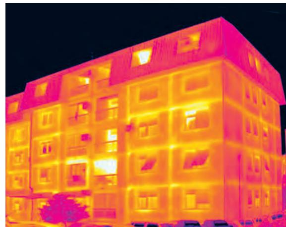
Стамбена зграда са фасадним зидовима од префабрикованих бетонских панела. Термограм приказује губитке топлоте на местима међусобних спојева панела и у мањем обиму на месту прихвата завршног слоја. Спојеви плоча тераса и фасадних зидова се карактеришу изразитим линијским губицима. Фасадна столарија релативно лошег квалитета са уочливим топлотним губицима нарочито у зони кутије за ролетну.
