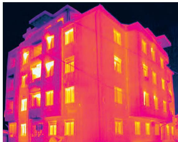
Стамбена зграда са масивним зидовима од гитер блока и фасадом изведеном у виду „контактне“ термоизоловане фасаде. На термограмму се уочава одсуство изразитих зона топлотних губитака осим на фасадној столарији и делимично на плочама еркера. Могуће је приметити тачкасте топле зоне настале као последица појаве зазора приликом постављања термоизолационих плоча.
