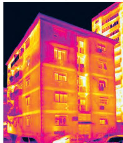
Стамбена зграда са масивним фасадним зидовима од Дурисол и бетонских блокова без термоизолације. Термограм приказује приметне губитке топлоте нарочито у зонама хоризонталних армирано бетонских серклажа и на спојевима појединачних блокова али и добитке од соларног зрачења (леви фасаде по последњег спрата). Фасадна стопарија је у лошем стању што резултира изразитим топлотним губицима.
