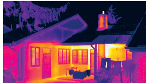
Породична кућа у низу са масивним фасадним зидовима од опеке и гитер блока без термоизолације. Кућа се греје у целости и на термограму се јасно може видети грејани део у виду приземне етаже и негрејани тавански простор. Најизраженији губици топлоте се јављају у зони армирано бетонских серклажа и натпрозорних греда. Конструкција прозора је неодговарајућа са изразитим топлотним губицима.
