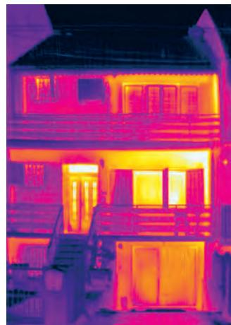
Породична кућа у низу са масивним фасадним зидовима од опеке без термоизолације. Кућа се греје у целости и на термограму се јасно може видети грејани део у односу на негрејани тавански простор. Најизраженији губици топлоте се јављају у зони армирано бетонских серклажа и натпрозорних греда. Конструкција прозора и врата је неодговарајућа са изразитим топлотним губицима.
