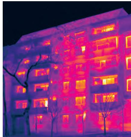
Стамбена зграда са масивним фасадним зидовима од опеке без термоизолације. Термограм приказује приметне губитке топлоте кроз фасадни зид нарочито у зонама хоризонталних армирано бетонских скрлажа, натпрозорних греда и на местима конзолно препуштених тераса. Оригинална фасадна столарија са изразитим губицима на спојевима оквира и у зони кутија за ролетне.
