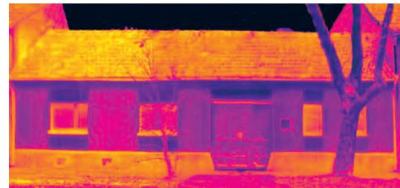
Породична кућа са изразито масивним, хомогеним, фасадним зидовима од опеке без термоизолације. Термограм приказује секундарно загревање од сунчевог зрачења са највећим интензитетом у зони кровова као и фасадним испунама између прозора. Делови зида изнад и испод прозора су бојени светлом рефлексивном бојом што за резултат има мање топлотне добитке. Приметни су губици топлоте у зони прозорских отвора.
