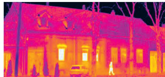
Породична кућа са изразито масивним, хомогеним, фасадним зидовима од ћерпича без термоизолације. Термограм приказује топлотне губитке кроз целокупну површину зидова са повећаним интензитетом у зони изнад прозорских отвора. Десна половина објекта се не греје. Конструкција прозора је неодговарајућа са изразитим топлотним губицима. Улазне капије и капци прозора се очитавају као топлији услед сунчевог зрачења.
