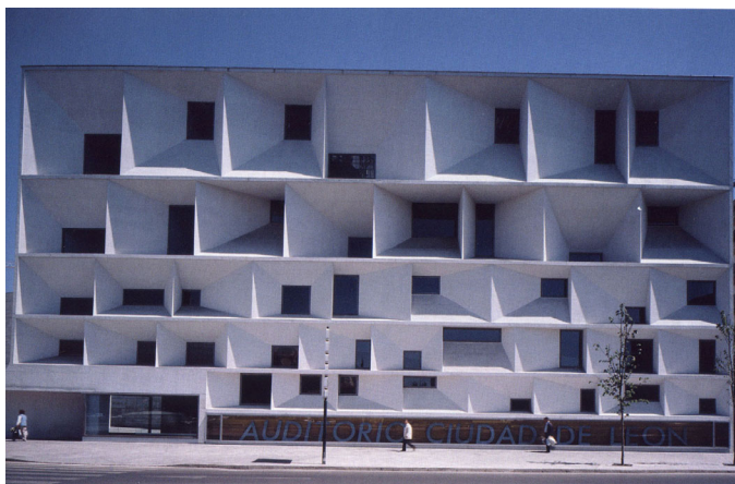
Слика 7. Дубоке прозорске нише као фиксна сенила
